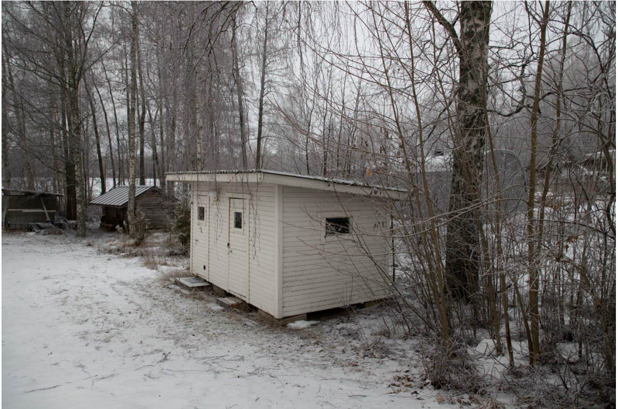
Kiinteistön Nuorronranta 211-467-1-188 talousrakennus (3).
