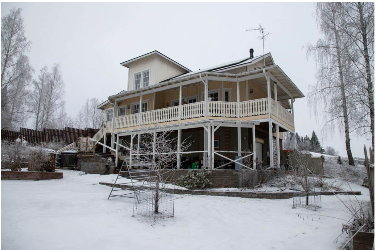
Kiinteistön Nuorronmaja 211-467-1-189 lomarakennus (5).
