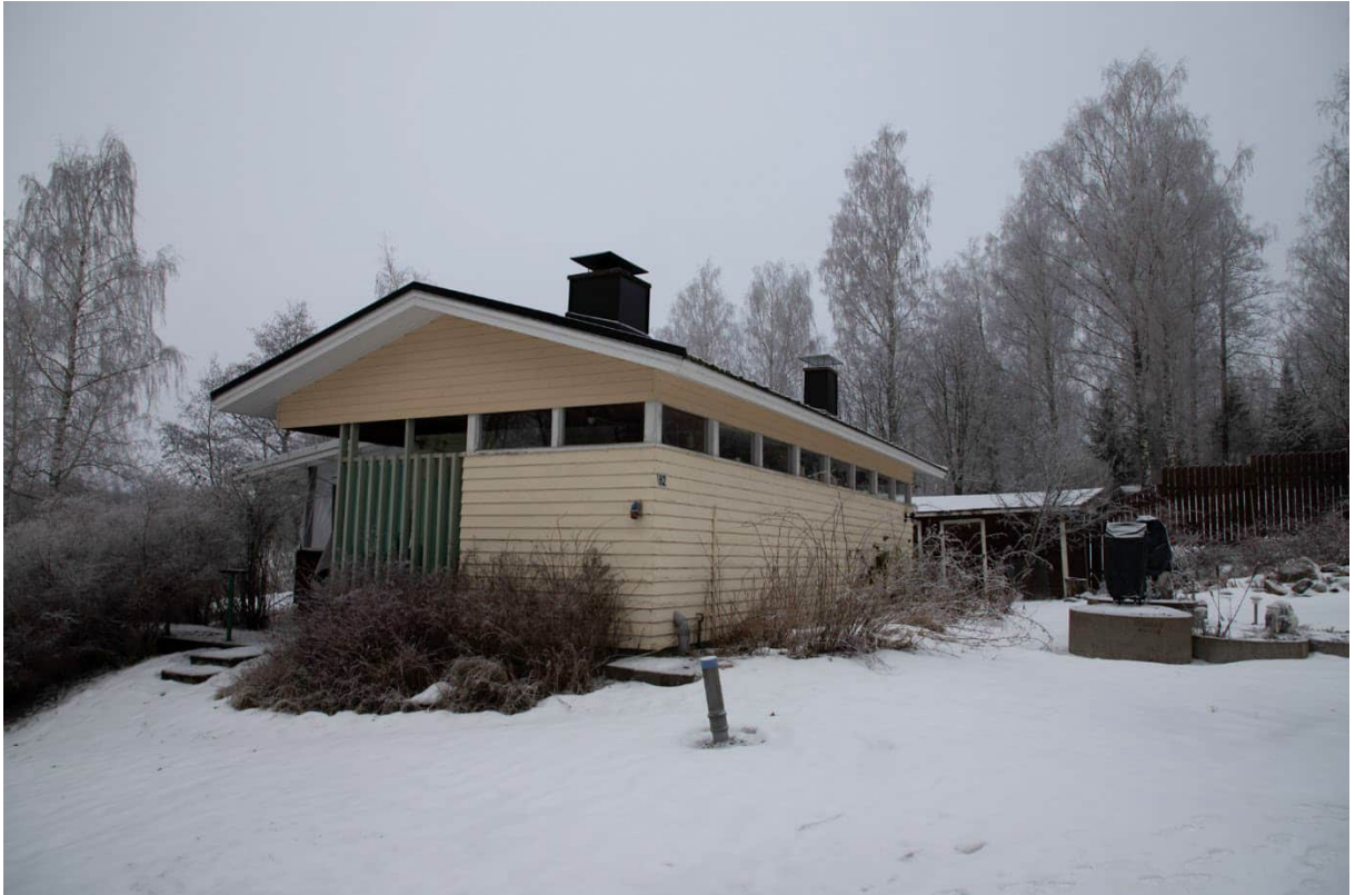
Kiinteistön Nuorronmaja 211-467-1-189 sauna- ja varastorakennus (6).
