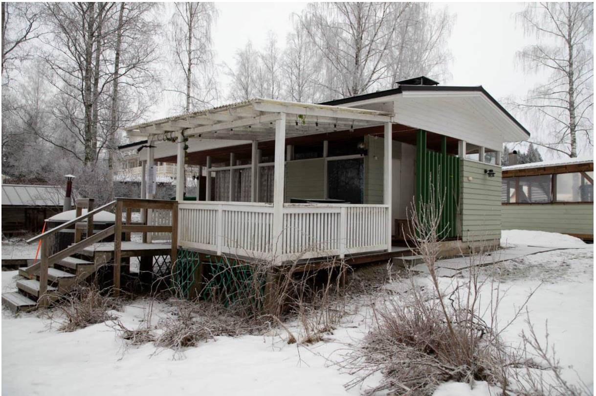
Kiinteistön Nuorronranta 211-467-1-188 vierasaitta ja varasto (2).
