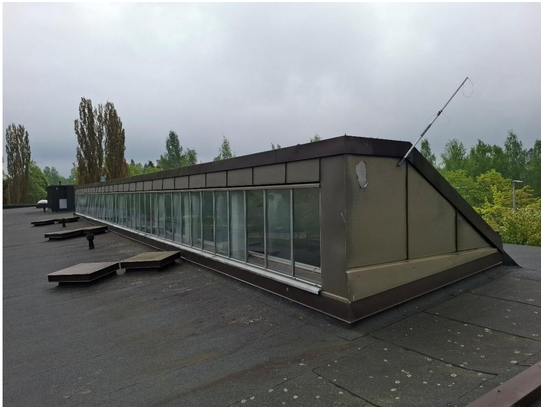
Kuva 11. Kattolyhdyt eivät ulkotilassa näy juuri muualle kuin kattotasolle.
