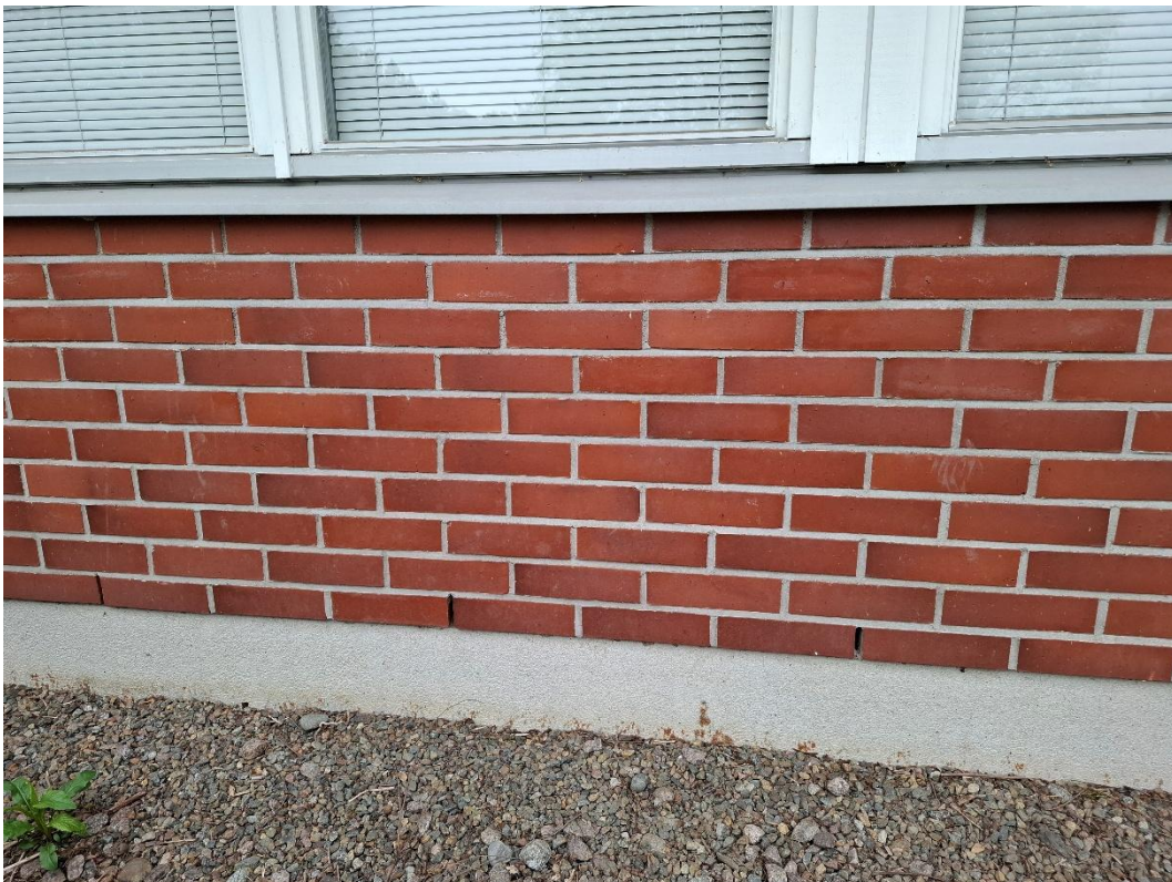
Kuva 10. Paikalla muuratut julkisivun osat tunnistaa alimman tiilirivin avoimista saumoista sekä elementtisaumojen puuttumisesta.
