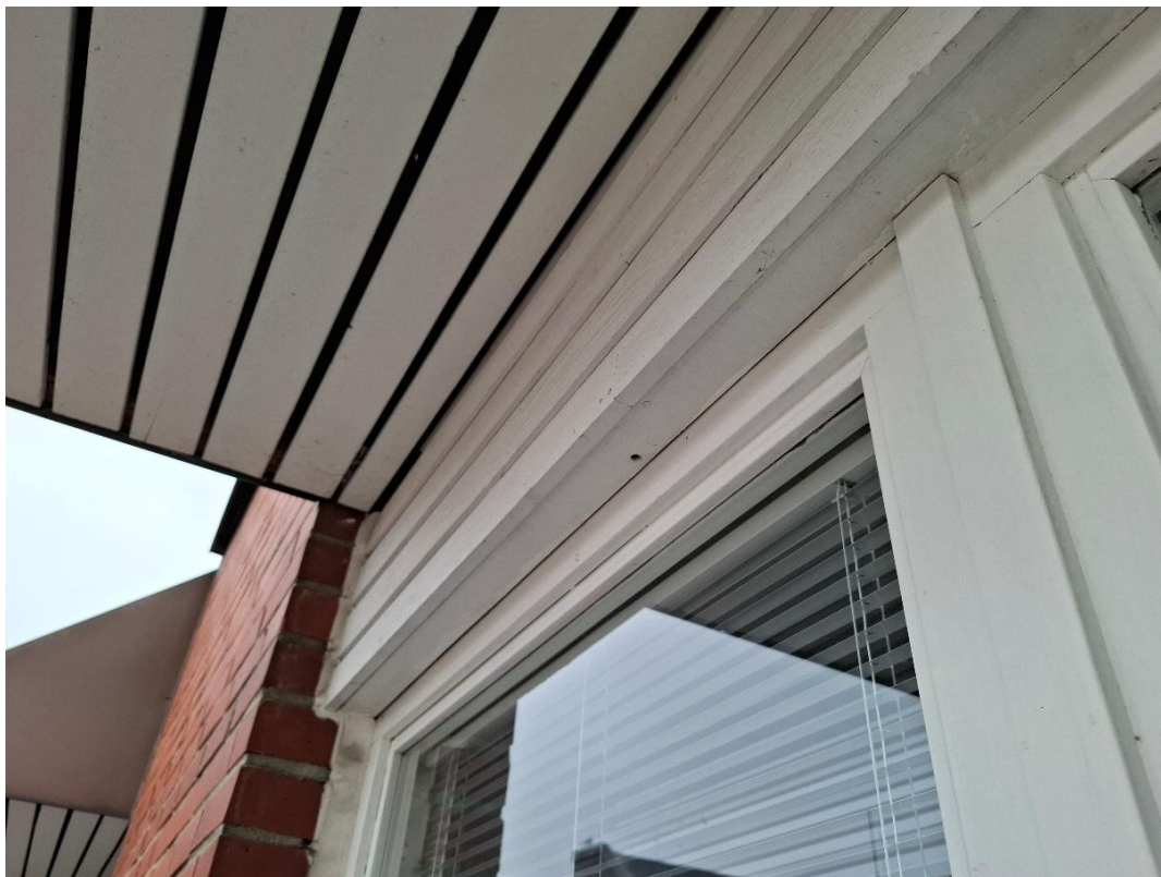
Kuva 25. Lipan alapinnassa on samankaltainen laudoitus kuin ikkunan yläpuolella, materiaali ikään kuin kääntyy seinästä lipan alapinnaksi.
