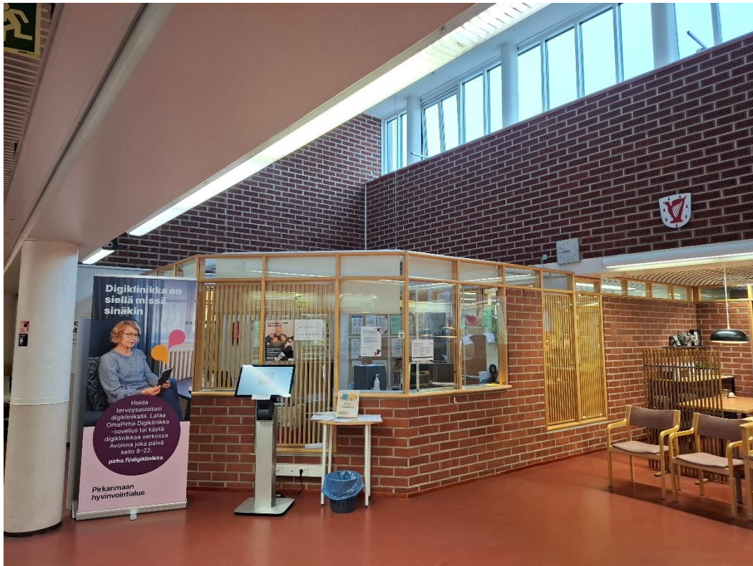
Kuva 15. Mahdollisesti myöhemmin rakennettua puu-lasiseinää joka liittyy alkuperäisiin tiilirakenteisiin.
