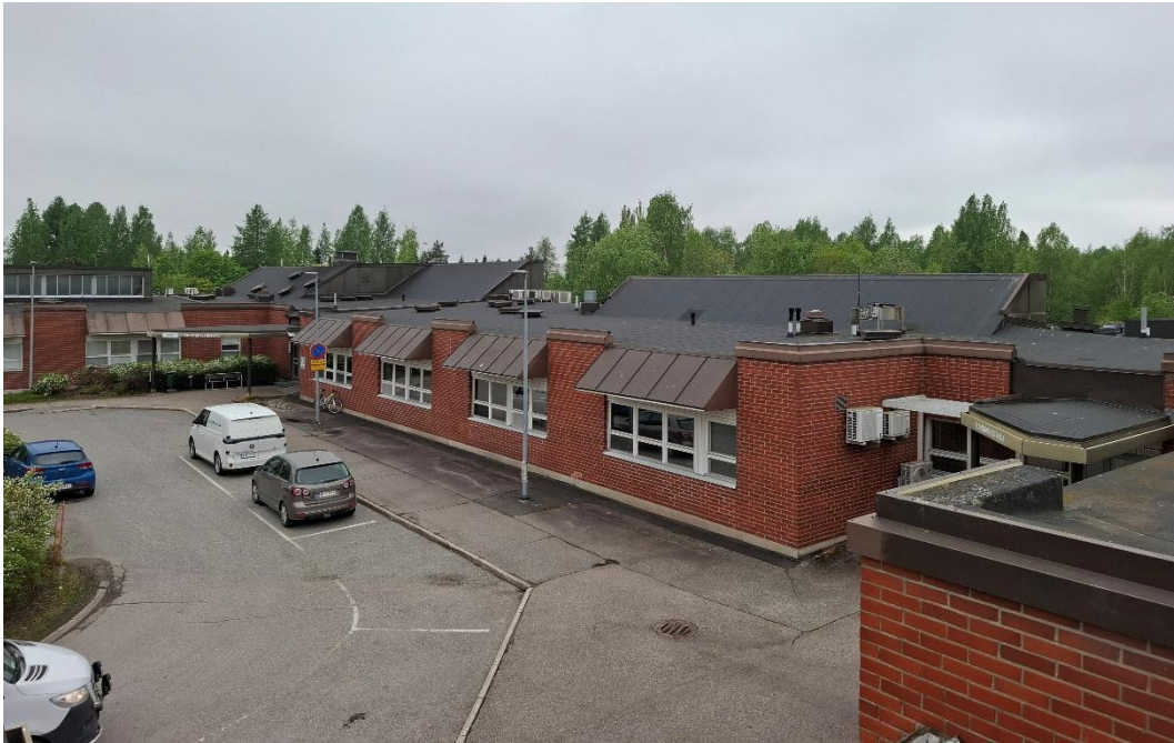
Kuva 7. Vanhinta osaa katolta katsottuna, jolloin kattolyhdytkin erottuvat.
