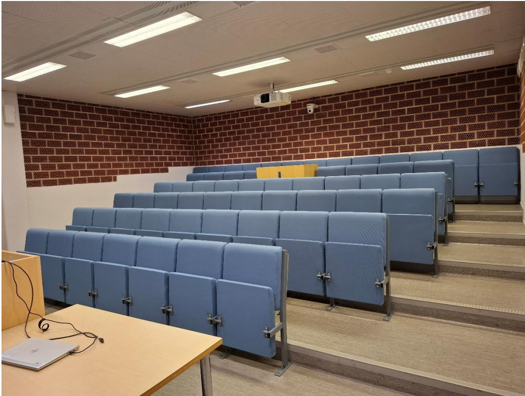
Kuva 27. Auditoriossa on akustoiva seinä tehty tiilellä.
