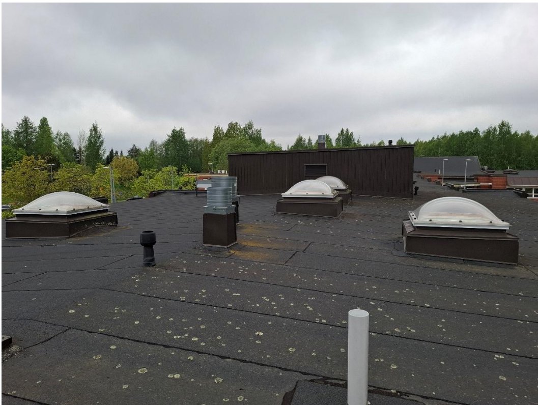
Kuva 36. Kattoikkunat ovat kupumallisia.
