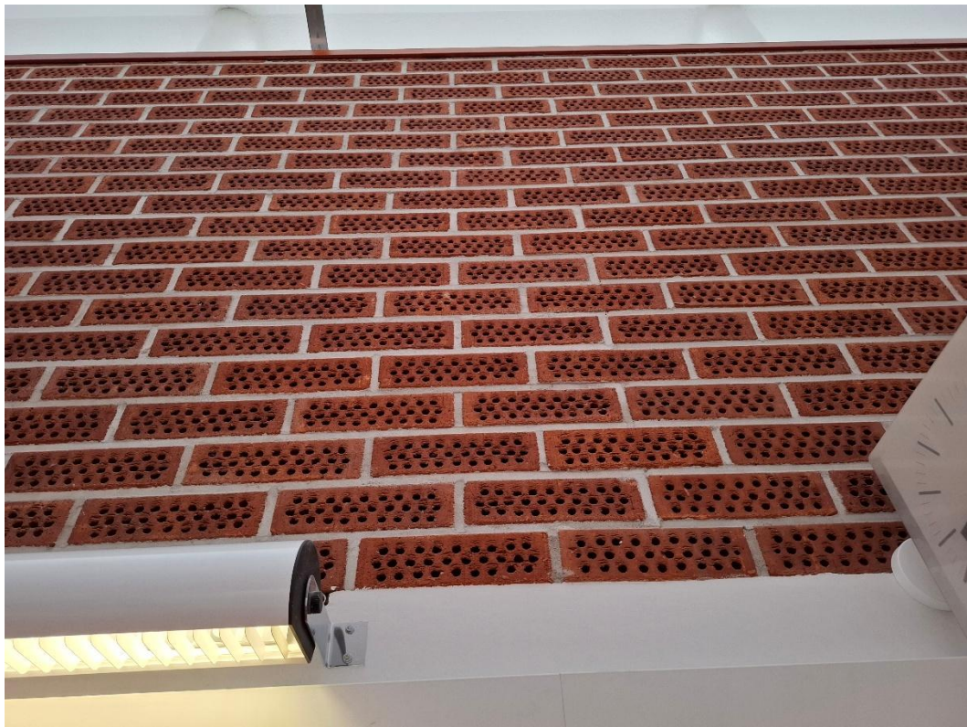
Kuva 14. Akustoivaa tiilipintaa, jossa reikätiilet on muurattu reiät sisätilaan päin.
