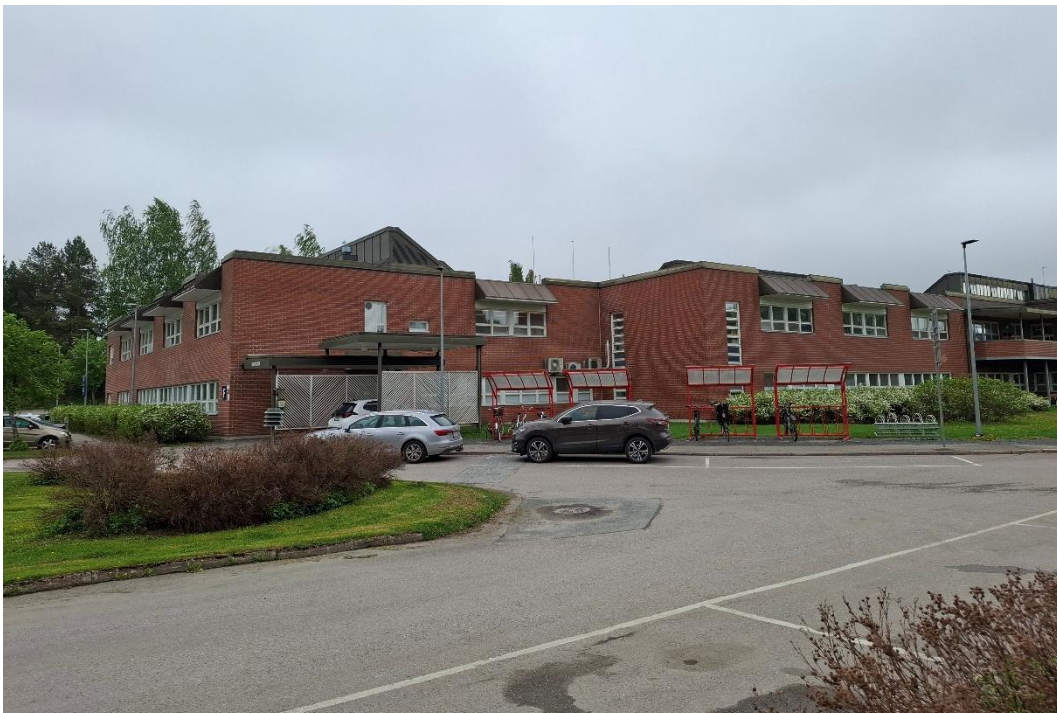
Kuva 22. Toisen ja ensimmäisen vaiheen kaksikerroksisten osuuksien liittymä.
