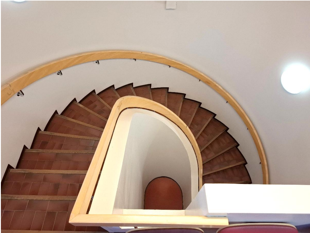
Kuva 17. Porras on muotoiltu huolella ja sen askelmat on laatoitettu tiililaatoilla, joiden värit on elävä.
