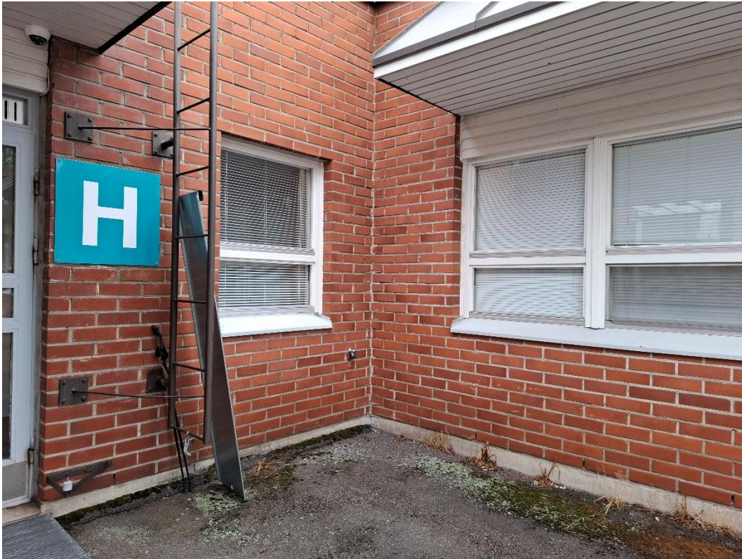
Kuva 23. Toisen ja ensimmäisen vaiheen osuuksien liittymä erottuu nurkan tiilimuurauksessa, jossa on koko seinän korkuinen nurkkasauma.
