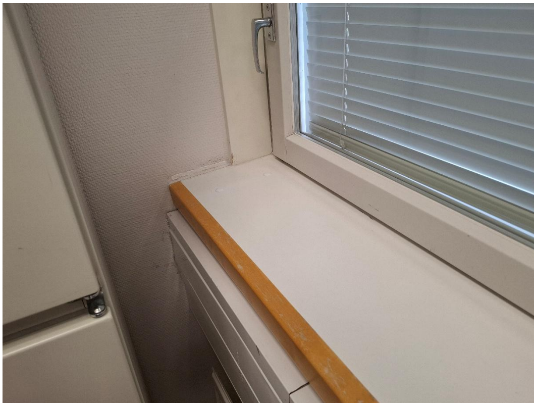
Kuva 19. Ikkunapenkkien reunat on huoliteltu puulistalla.
