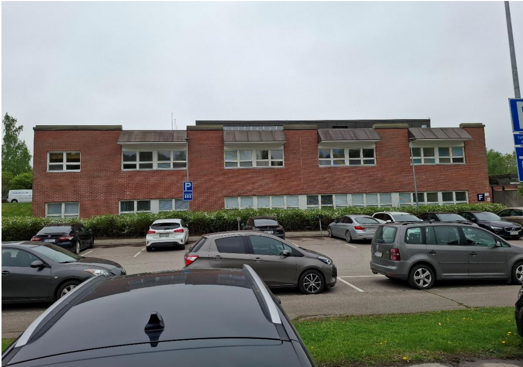
Kuva 21. Toisen rakennusvaiheen kaksikerroksinen osuus. Julkisivuissa ei ole räystäskouruja tai syöksytoria, koska katon sadevedet johdetaan maahan lippojen kautta.
