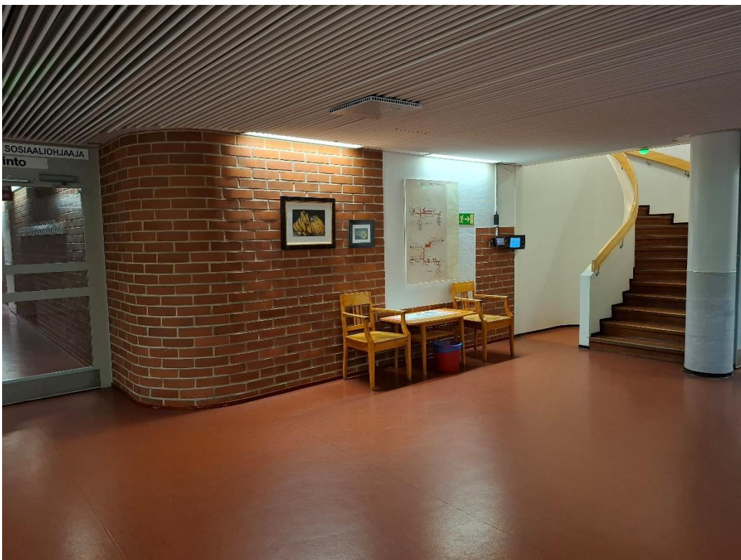
Kuva 18. Tiiliseinän nurkka on pyöristetty samaan tapaan kuin porras toiseen kerrokseen.
