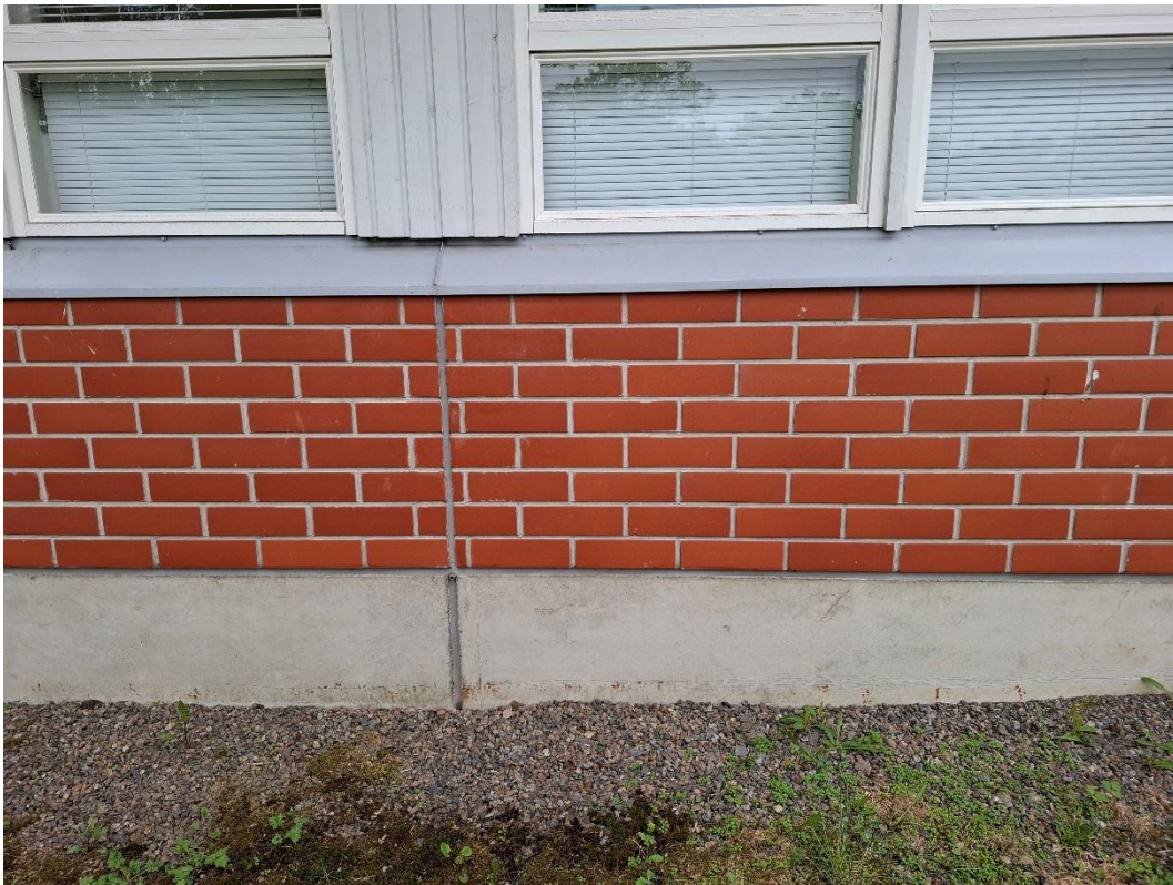
Kuva 35. Julkisivut ovat laajennusosassa tiililaattapintaisia betonielementtejä.
