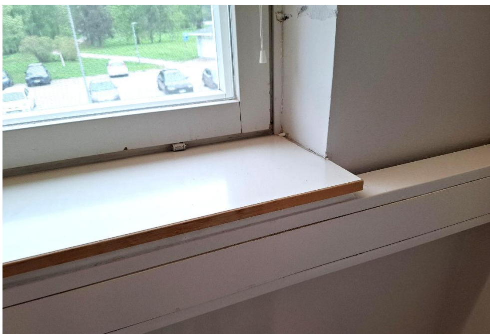
Kuva 30. Toisen vaiheen ikkunapenkeissä on myös puulista reunassa, mutta se on ohuempi kuin ensimmäisessä vaiheessa.
