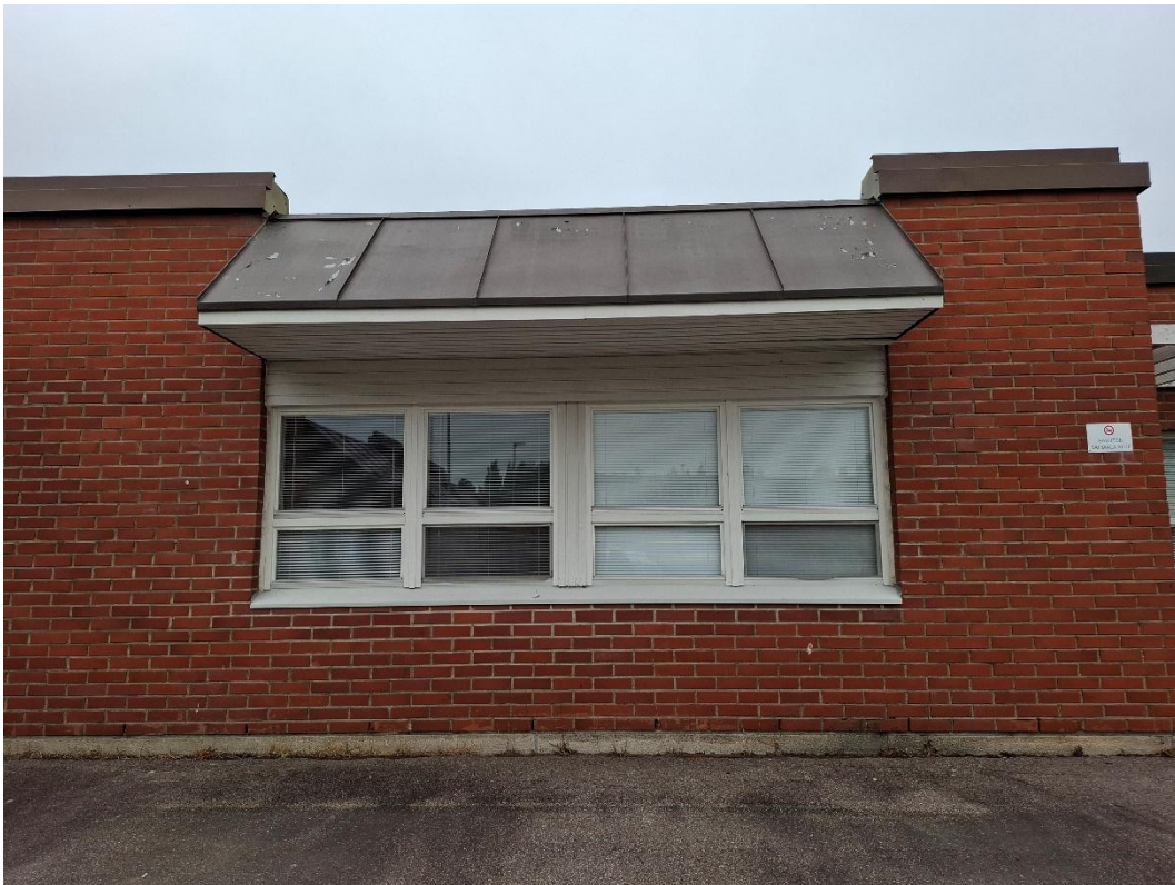
Kuva 24. Lippa toimii katon sadevedenpoistoreittinä.
