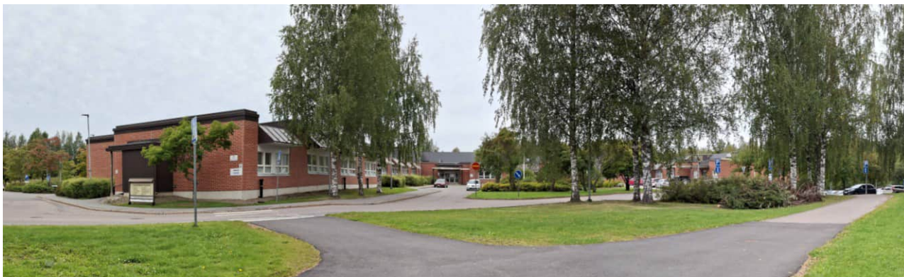
Kuva 20. Panoraamakuva terveysaseman itäpuoliselta piha-alueelta. Vasemmalla vuonna 2004 valmistuneen yksikerroksisen laajennusosan (laajennus 5 työterveyshuolto) itäpääty, joka on sisäänajoa lähimpänä sijaitseva rakennuksen osa ja näkymäpääte. Kuvan etualalla näkyy Herttualantien ylittävän suojatien jatkona olevia jalankulun reittejä. (Kuva: Kangasalan kaupunki, kaavoitus 29.8.2025)
