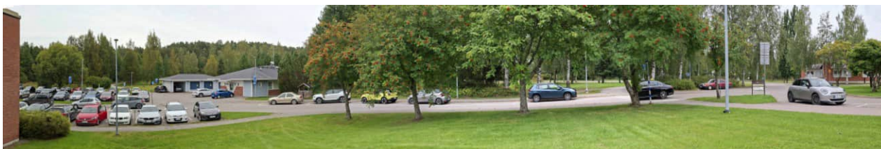
Kuva 22. Panoraamakuva terveysaseman pihalta. Kuvan vasemmassa laidassa näkyy pieni osa vuonna 1988 valmistuneen laajennusosan (neuvolan laajennus) itäpäädyestä. Terveysaseman rakennusten pohjoispuolisen pysäköintialueen takana näkyvät vuonna 1992 valmistuneet ympäristöterveydenhuollon rakennus ja huoltorakennus. Kuvan oikeassa laidassa pilkottaa vuonna 2004 valmistunut terveysaseman yksikerroksinen laajennusosa (laajennus 5 työterveyshuolto). (Kuva: Kangasalan kaupunki, kaavoitus 29.8.2025)
