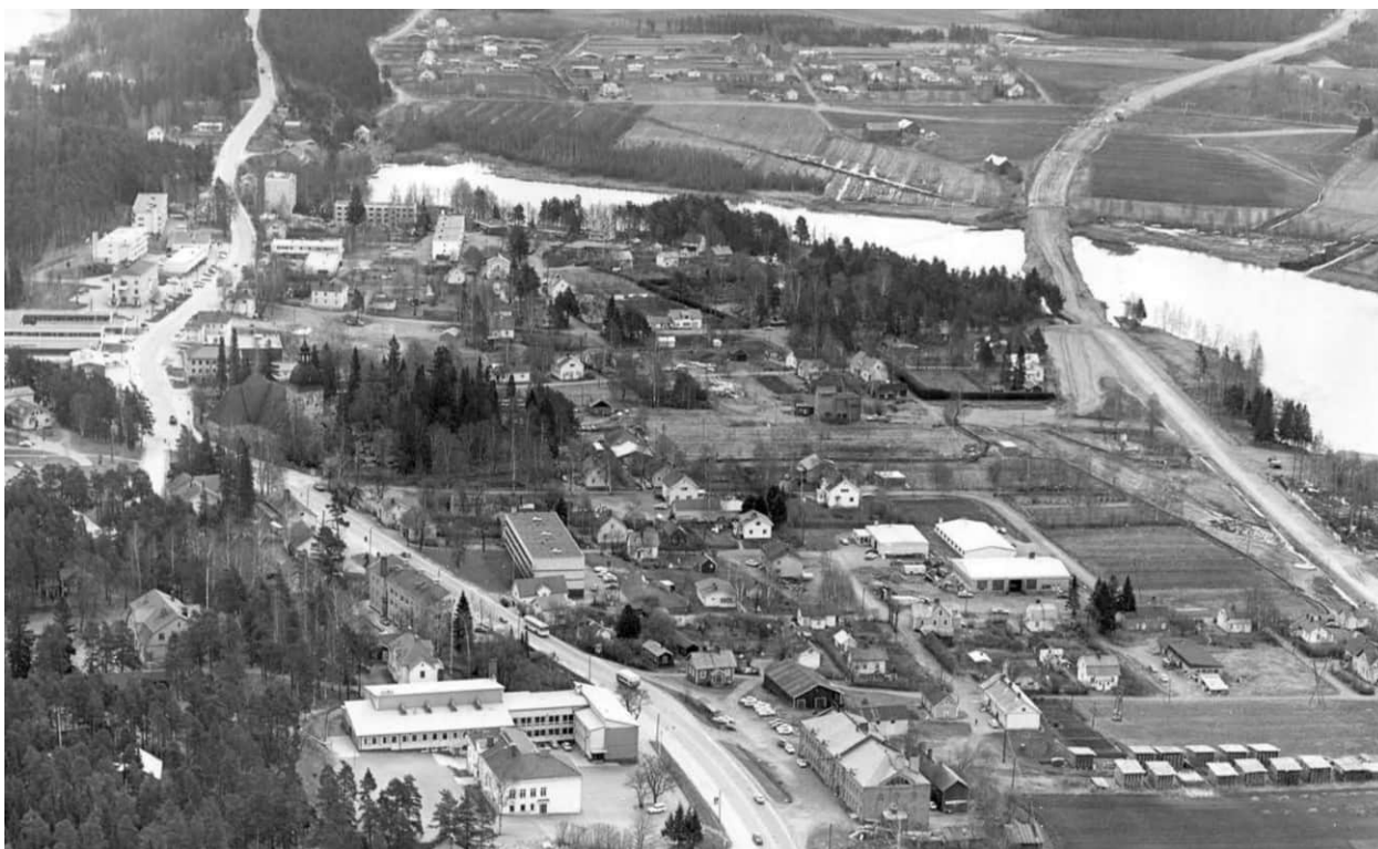
Kuva 3. Näkymä Kangasalan keskustan yli vuonna 1974. Katselusuunta on lännestä itään. Kuvan alalaidassa näkyy Kirkkoharjun koulu ja taka-alalla Kirkkojärven vastakkaisella puolella sijaitseva kaavan suunnittelualue. Valtatien 12 rakentaminen on parhaillaan käynnissä. Kuva: Kangasalan kaupunki, ote kirjasta "Edelläkävijän roolissa – Kangasalan kaavoitus 50 vuotta".
