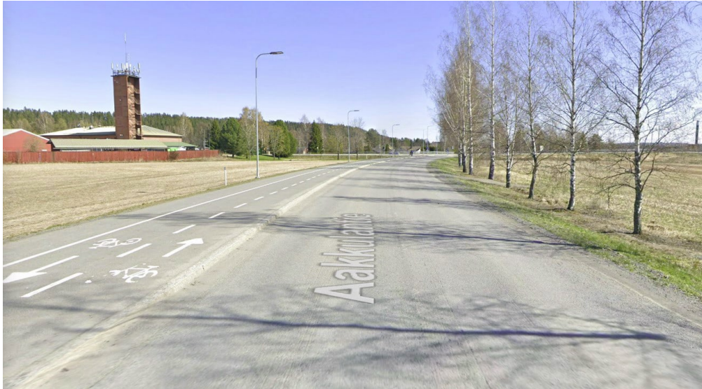
Kuva 14. Aakkulantiellä kaava-alueen kohdalla on eroteltu kaksisuuntainen pyörätie ja jalkakäytävä. (Lähde Google Street View, kuva otettu huhtikuussa 2025, katsottu 19.09.2025, https://maps.google.com )
