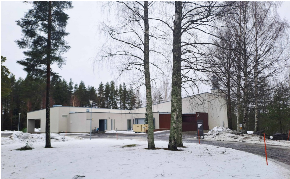
Kuva 6. Kuva vuonna 2013 rakennetusta Vatialan krematoriosta talvella 2025.
