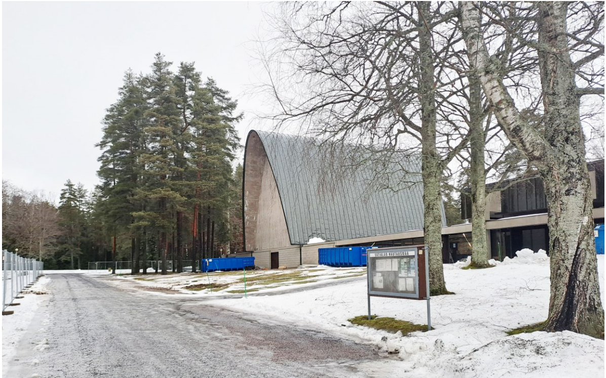
Kuva 5. Vatialan siunauskappeli talvella 2025. Kohteessa oli korjaustyöt meneillään.
