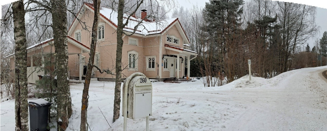
Kuva 27. Näkymä Kuohunharjuntieltä, osoitteessa Kuohunharjuntie 260 (211-410-1-60 Majjala) sijaitseva asuinrakennus ja autokatos. (Kuva: Kangasalan kaupunki, kaavoitus tammikuu 2026)
