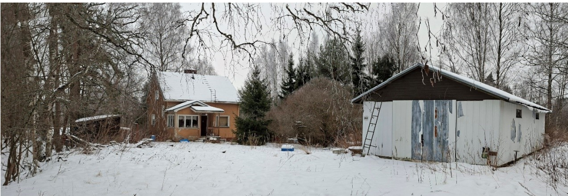
Kuva 28. Näkymä Kuohunharjuntieltä, osoitteessa Kuohunharjuntie 262 (211-410-1-61 Kankaanpää) sijaitsevat asuin- ja talousrakennukset. (Kuva: Kangasalan kaupunki, kaavoitus tammikuu 2026)
