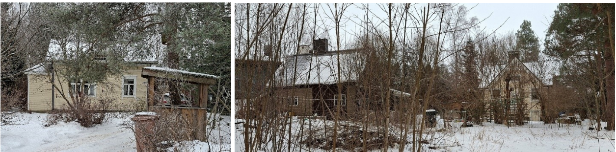
Kuva 25. Osoitteessa Kuohunharjuntie 254 (211-410-1-8 Laurila) sijaitsevat asuin- ja talousrakennukset. Vasemmalla näkymä Kuohunharjuntieltä ja oikealla pihaa rajaavan metsikön suunnalta. (Kuva: Kangasalan kaupunki, kaavoitus tammikuu 2026)
