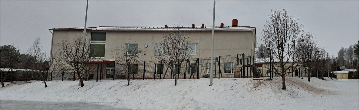
Kuva 24. Vuonna 2016 valmistuneen koulun laajennuksen eteläjulkisivu. (Kuva: Kangasalan kaupunki, kaavoitus tammikuu 2026)
