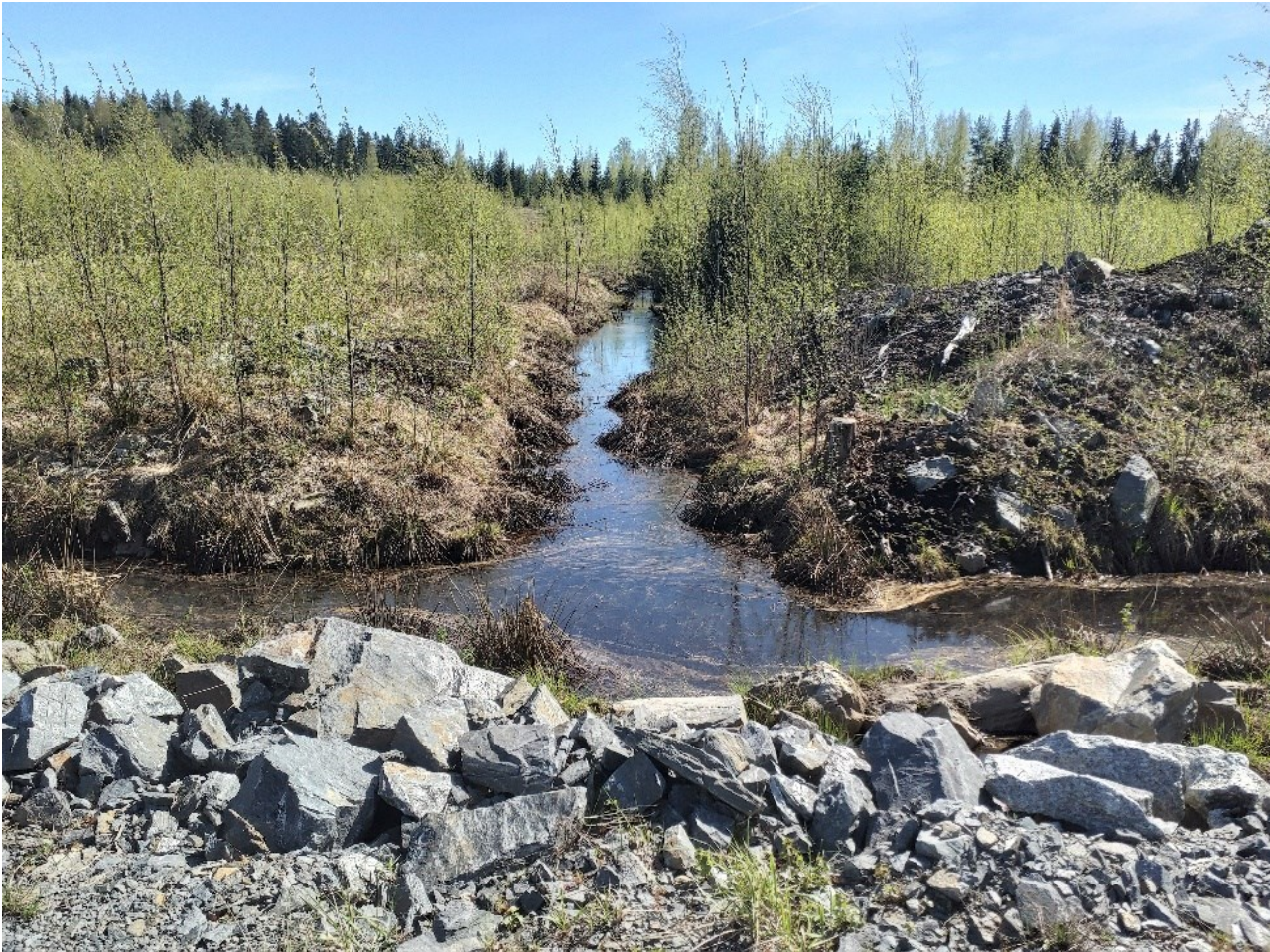
Kuva 25. Tarasjärven ja Tarastentien eteläpuolella sijaitsevissa kaivanto-ojissa kuului myös viitasammakoita.
