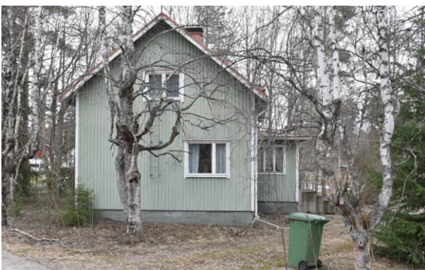
Kuva: Puolitoistakerroksinen puutalo. Ikkunat on uusittu vuorilautojen sirous säilyttäen.
