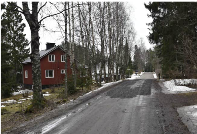
Kuva: Puolitoistakerroksisia tyyppitaloja sijoiteltuna vinosti katuun nähden.
