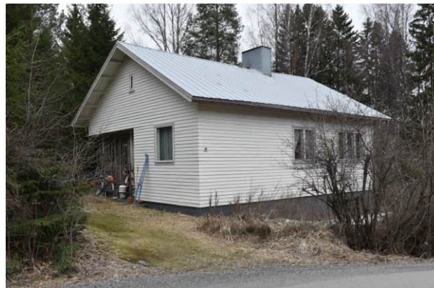
Kuva: Lähes alkuperäisessä asussa säilynyt talo (ikkunamuutos päädyssä).
