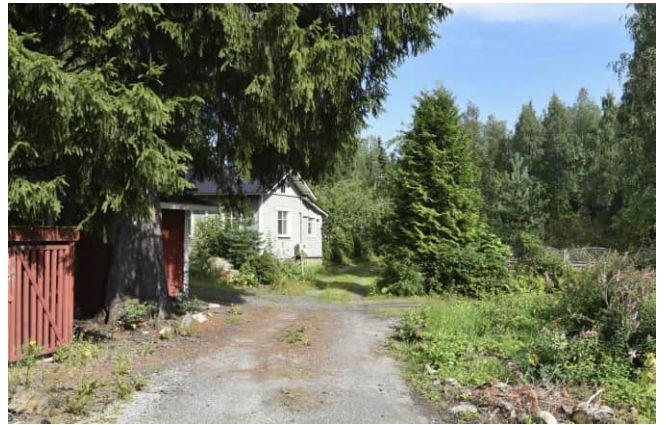
Kuva: Kuvassa Karjasillantie 40 n. 1920–30-luvulta (vanhan tien vieressä)
