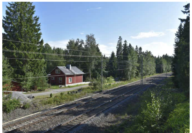
Kuva: Karjasillantie 33 ja kaksiraiteinen ratapiha.
