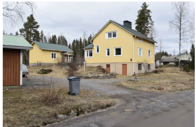
Kuva: Asuin- ja piharakennusten rajaama piha, jossa kohtuullisen vähäisin muutoksin säilynyt sotienjälkeinen puolitoistakerroksinen tyyppitalo.
