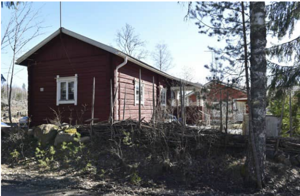
Kuva: Kaksi Markkulan muonamiesten hirsirunkoista asuinrakennusta on vastakkain Muistomerkintien varrella. Molempien pihapiiriin on rakennettu uudisrakennus. Kuvassa on hirsipinnalla oleva ”Kivistö”.
