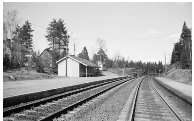
Kuva: Ruutanen liikennepaikka 4.5.1973. Sähköistys Tampereelta Jyväskylään otettiin käyttöön 3.10.1994. Laiturvaihderakennus oli saanut laudoitukset ikkunoihinsa. / Kuvaaja: Tapio Keränen Vaunut.org. Lisätty: 06.02.2024 20:24
