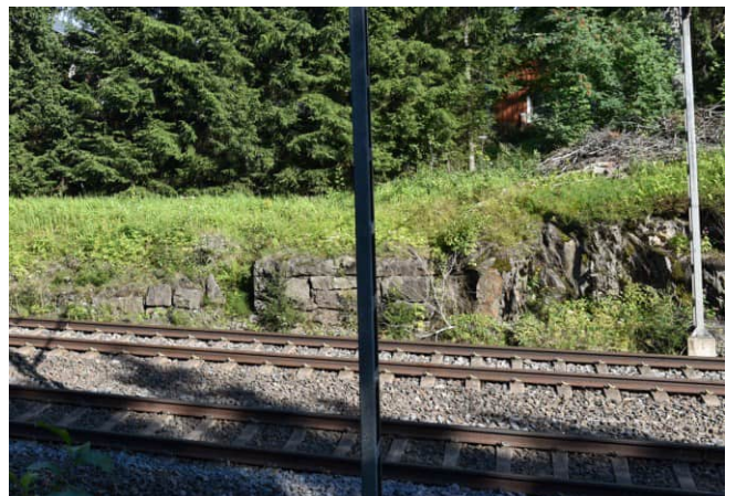
Kuva: Lohkokivistä ladottu tukimuuria on kallioleikkauksen sivussa entisen Halimaan pysäkin luona.
