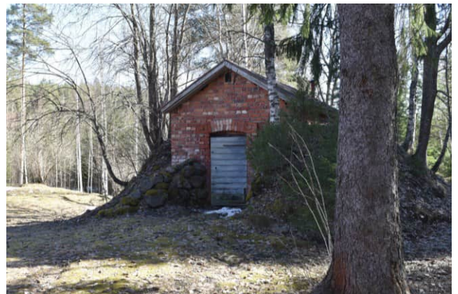
Kuva: Pysäkin vanha tiiliseinäinen maakellari.
