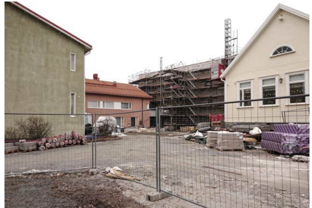
Kuva: Uuden koulun rakennustyö meneillään (2024). Vasemmalla näkyvät rakennukset puretaan.
