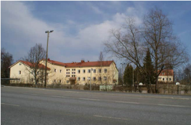
Kuva: Ruutanan kivikoulu ja puukoulu (kuva 2009). Kivikoulu purettiin kesällä 2024, mutta puukoulu säilyy.
