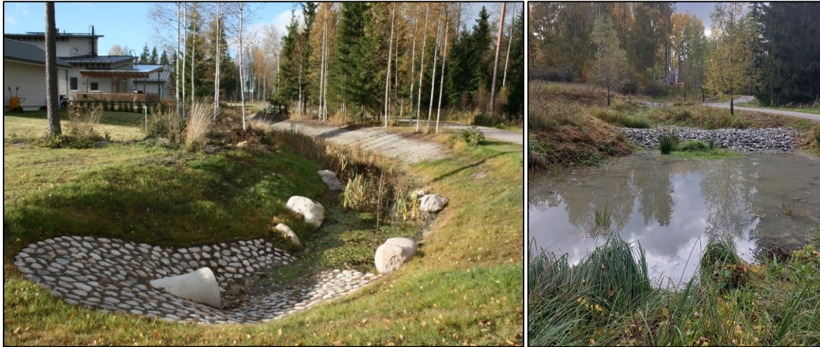
Kuva 15 Hulevesiä viivyttävä ja pidättävä oja vasemmalla (Vantaa, Renko 2015) ja hulevesien viivytysallas suotopadolla oikealla (Turku, Jaaninoja, Pääskyvuori 2022)
