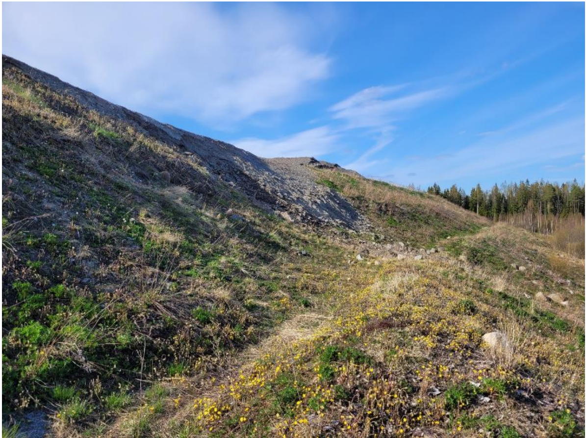
Kuva 4. Penkan reunan pieni sortuma 9.5.2023. (Ramboll Finland Oy/Ketola)
