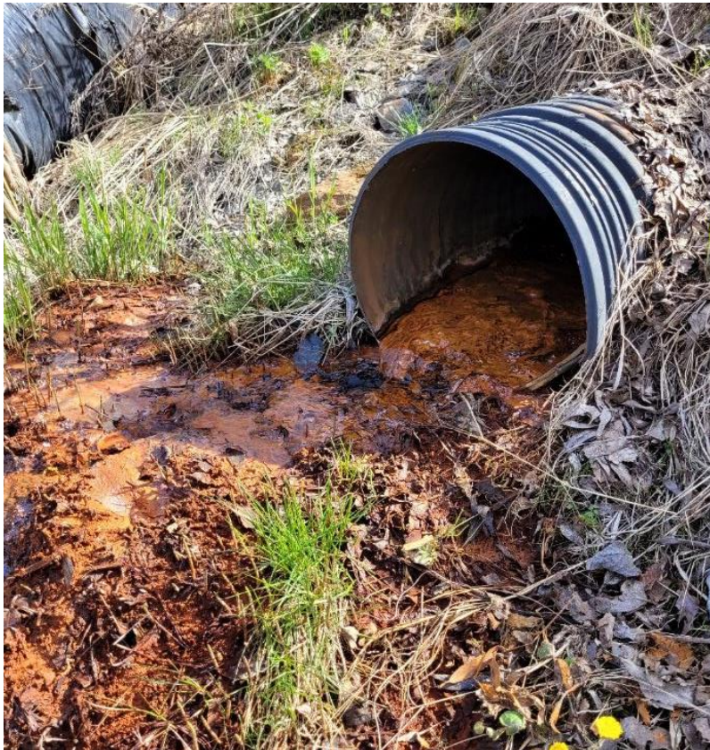
Kuva 2. Näytepisteessä PE1 toimiva purkuputken pää oli hyvin sakkainen 9.5.2023. (Ramboll Finland Oy/Ketola)
