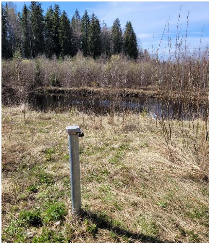
Kuva 3. Pohjavesiputki PVP4 9.5.2023. (Ramboll Finland Oy/Ketola)
