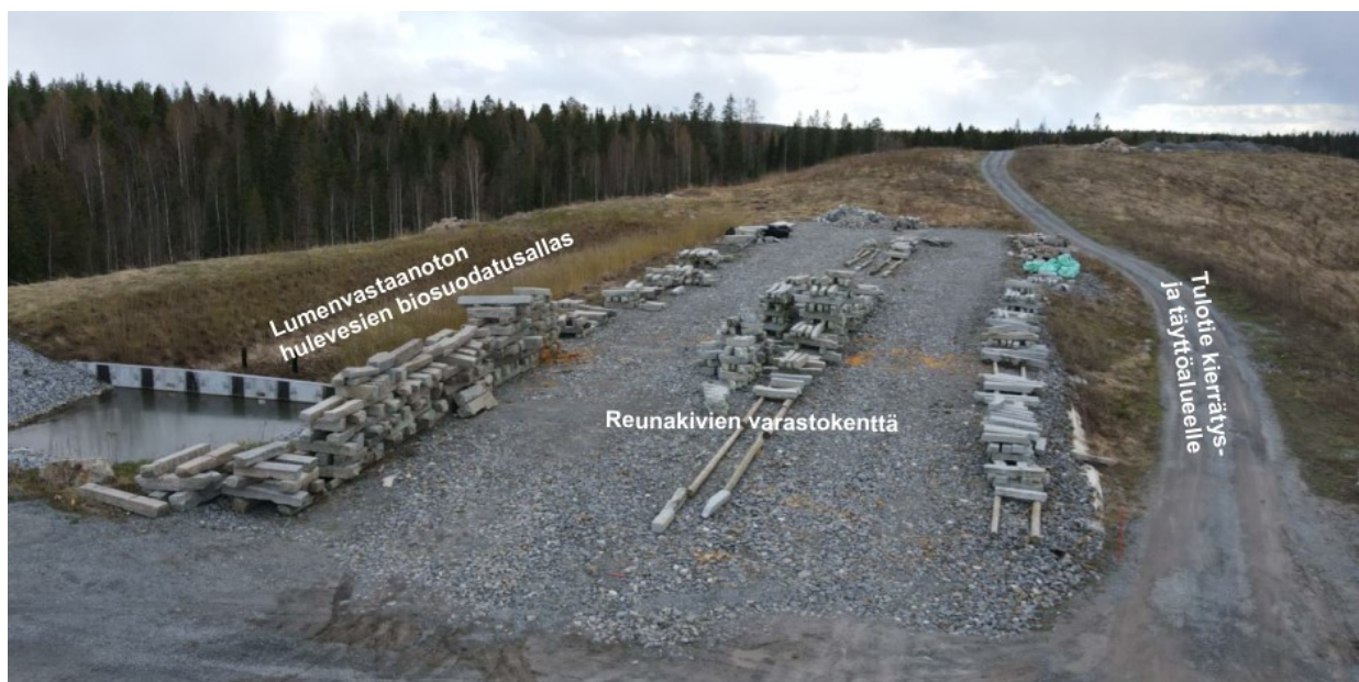
Kuva 9. Nykyisiä toimintoja: lumenvastaanoton sulamisvesien biosuodatusallas ja reunakivivarasto
