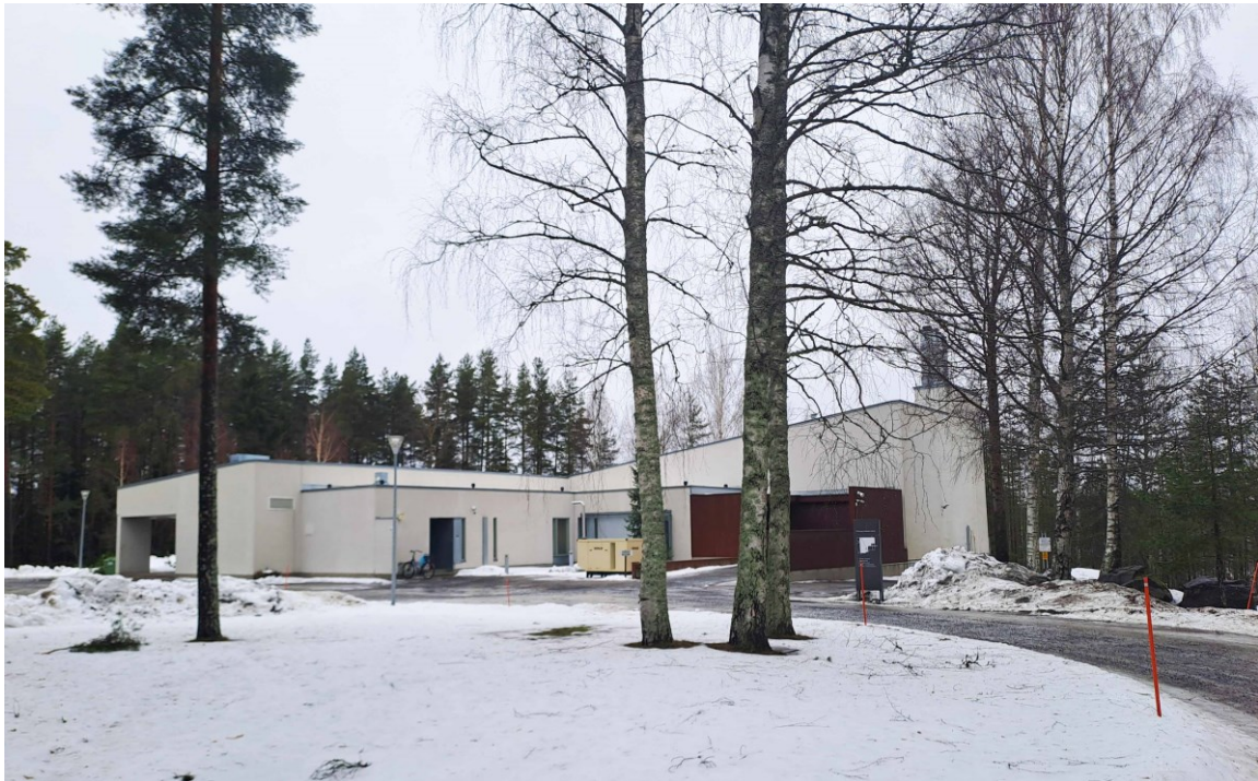
Kuva 6. Kuva vuonna 2013 rakennetusta Vatialan krematoriosta talvella 2025.
