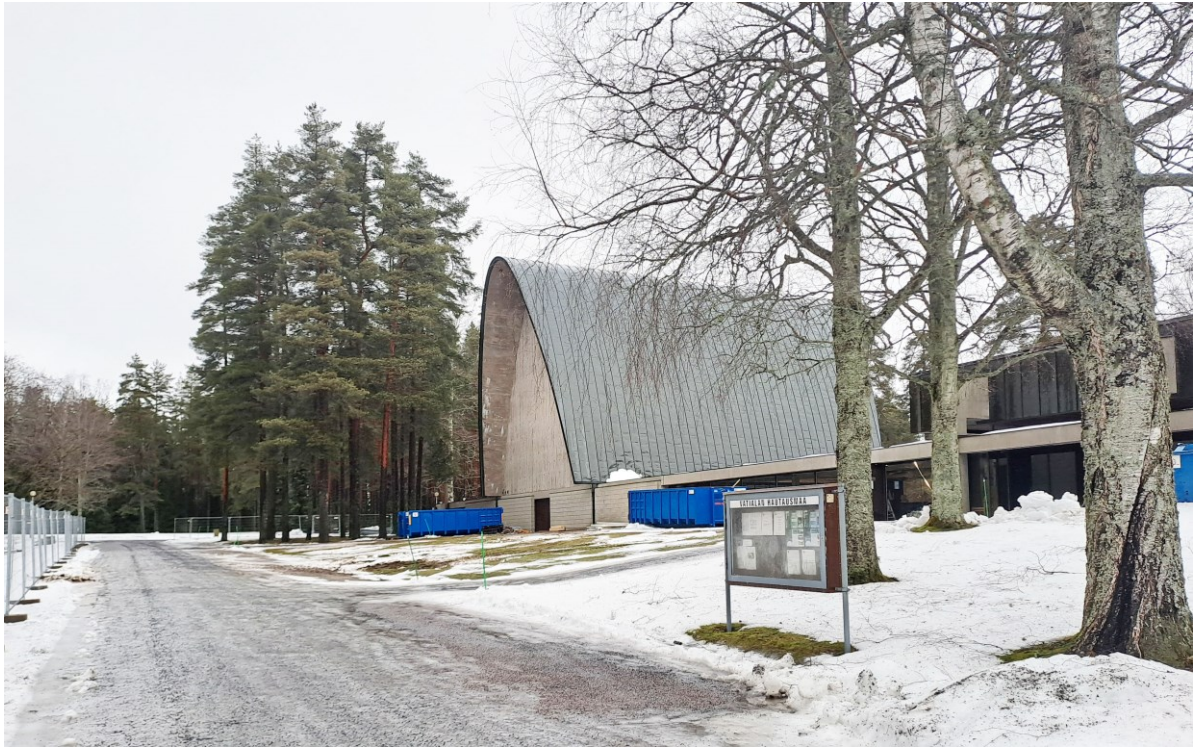
Kuva 5. Vatialan siunauskappeli talvella 2025. Kohteessa oli korjaustyöt meneillään.
