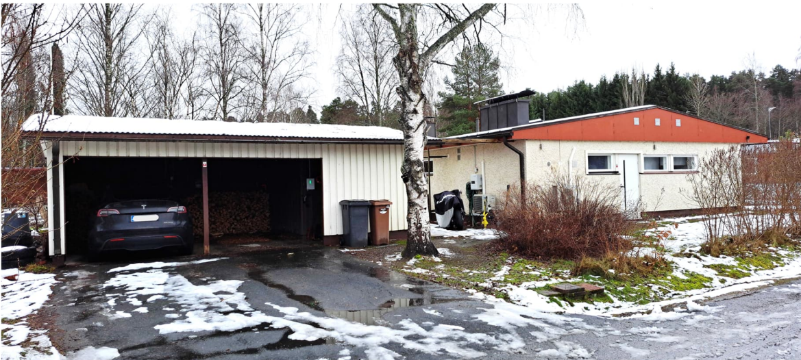
Kuva 10. Jaettavan tontin asuinrakennus ja autosuoja säilyvät nykyisellään. Kaavamuutos kuitenkin mahdollistaa kaksikerroksisen rakennuksen rakentamisen. Kuva: Kangasalan kaupunki 5.11.2024.
