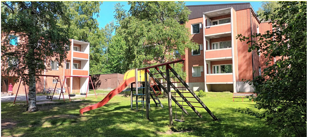
Kuva 5 ja 6. Kaavamuutosalueella sijaitsee nykyisellään kaksi huonokuntoista 1980-luvulla rakennettua kolmekerroksista asuinkerrostaloa, sekä talousrakennus.
