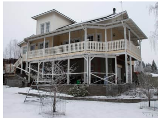
Lomarakennus kiinteistössä Nuorronmaja 211-467-189.
