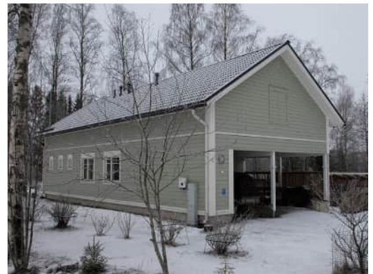
Lomarakennus kiinteistössä Nuorronranta 211-467-1-188.
