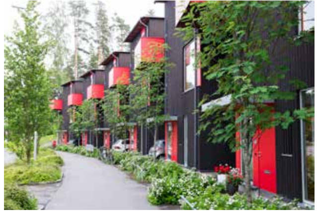
KUVA 22. Puisia kaupunkirivitaloja Omenamäen puutaloalueella Helsingissä. (MV)
