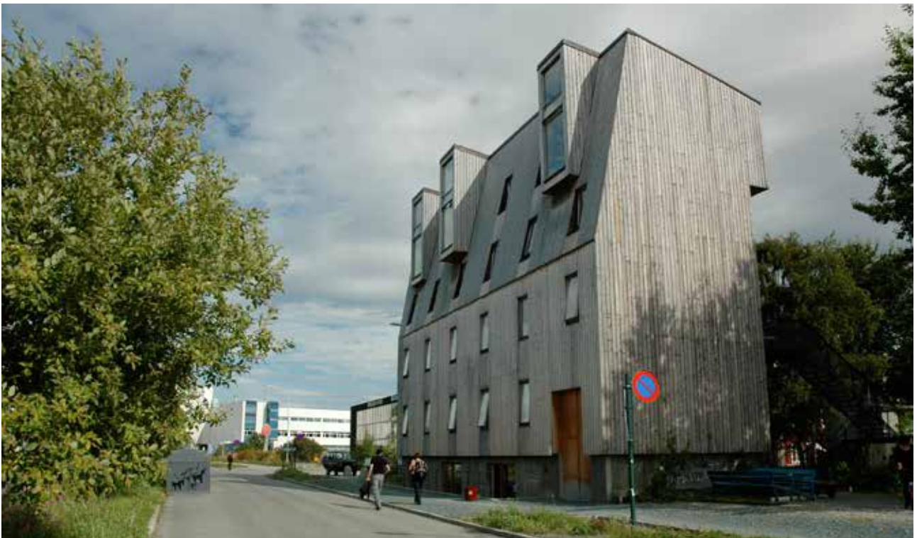
KUVA 24. CLT- puuelementeistä rakennettu kerrostalo Norjan Trondheimissa. Brendeland & Kristoffersen Arkitekter. (MV)
