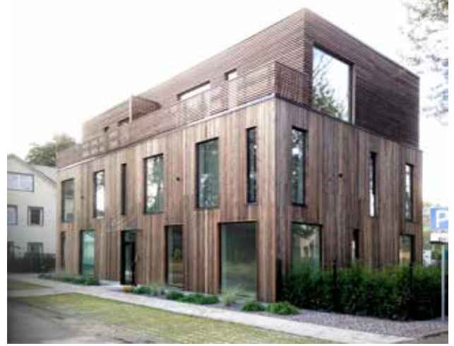
KUVA 36. Tallinnalainen kaupunkivilla, jossa on puuverhous
