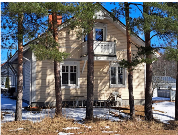
Kuva 7. Naapurin asuinrakennus alueen länsipuolella.
