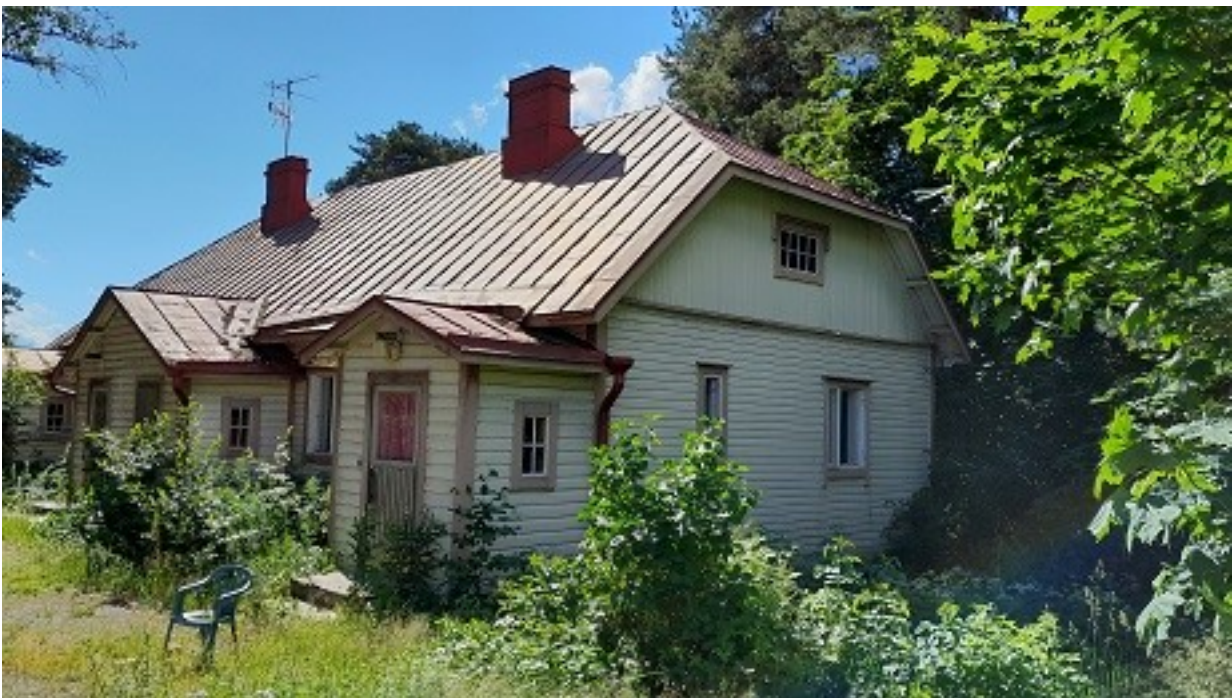
Vanhainkodin työvään asuinrakennus kuvattuna 2022 luoteesta.
