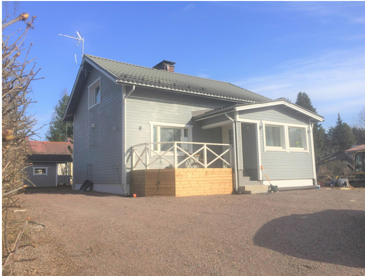
Kuva tontilta. Tontin nykyinen päärakennus on puolitoistakerroksinen ja harjakattoinen. Lisäksi tontilla on piharakennus.
