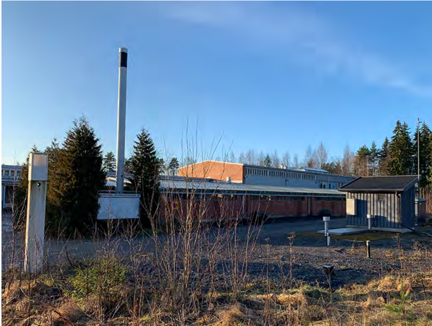
Näkymä alueelle Sahalahdentieltä liittymän kohdalta.
