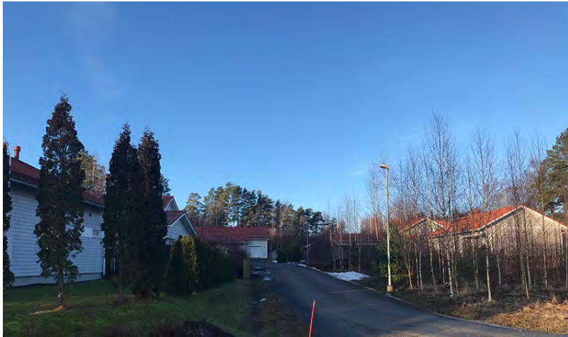
Kaava-alueeseen rajoittuvaa Iskoskujan varren 2000-luvun rakennuskantaa.
