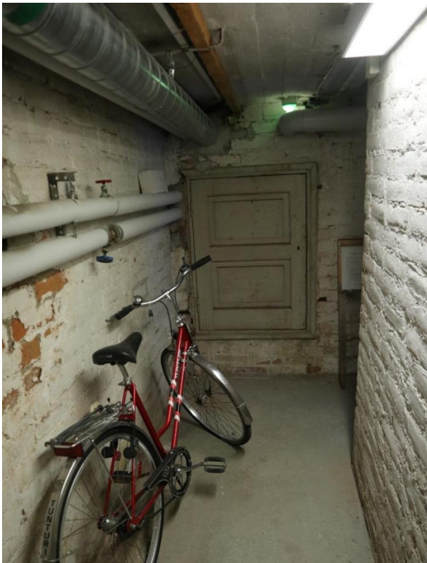
Kuva 72. Kellaria kiertävä huoltokäytävä on säilynyt alkuperäisenä.
