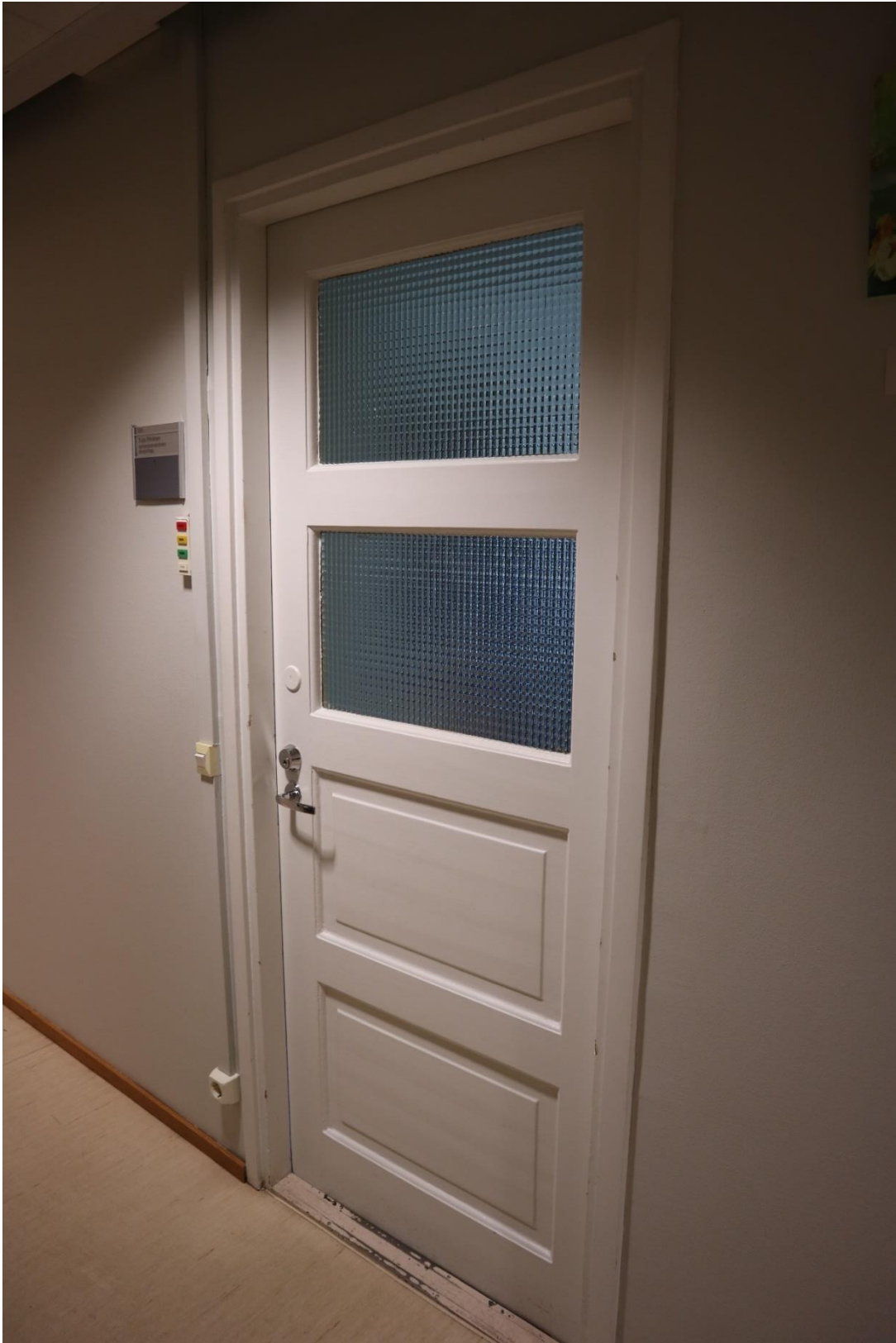
Kuva 66. Lasitettu peiliovi kolmannessa kerroksessa.
