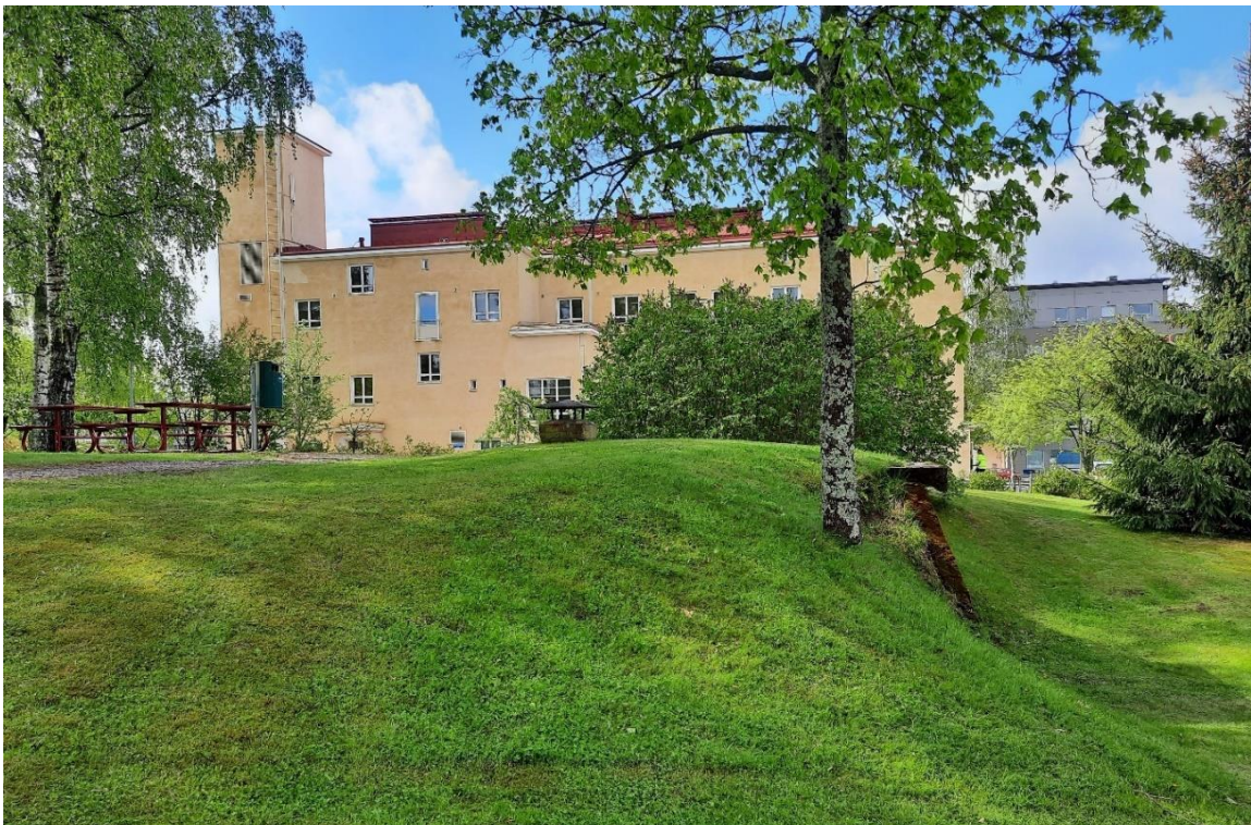
Kuva 39. Kaupungintalon takapihalla on tiilirakenteinen, osittain betonoitu maakellari.
