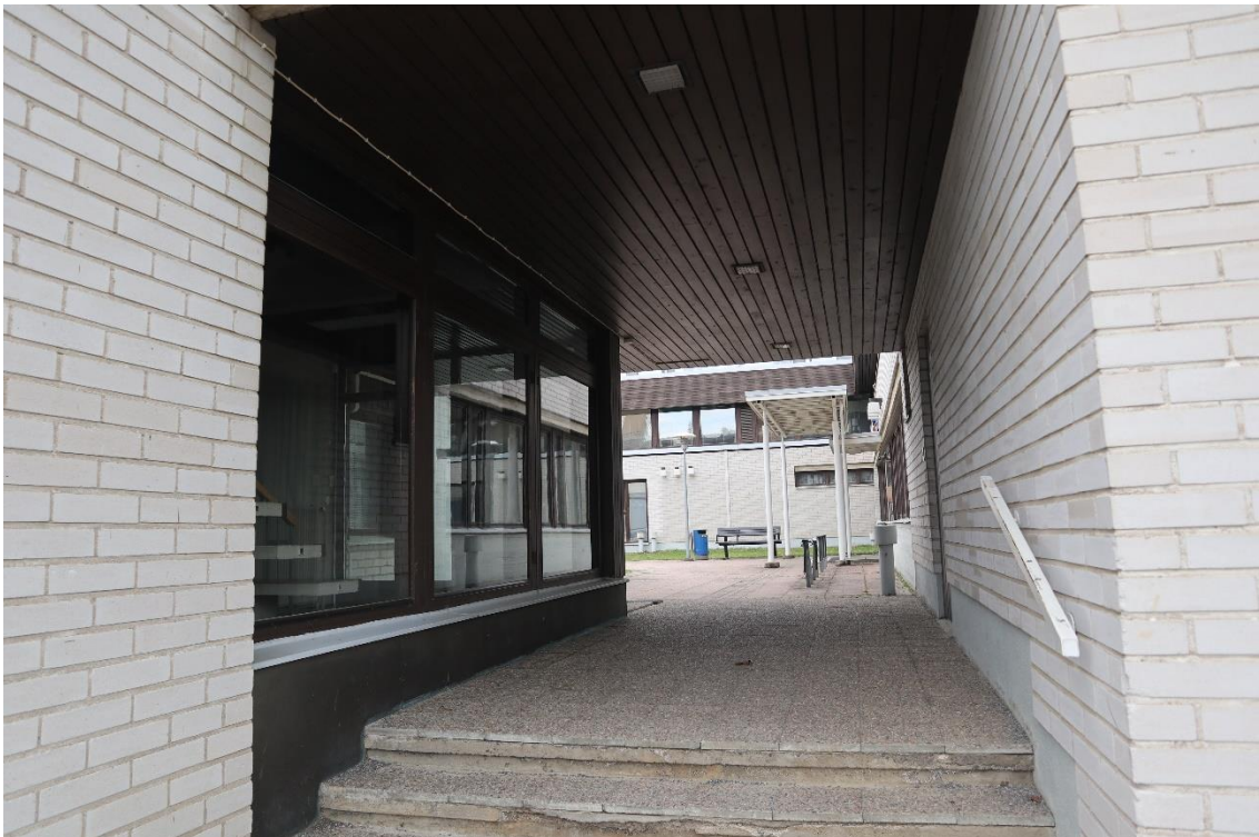
Kuva 89. Kaakkoispuolella on kulkuyhteys virastotalon sisäpihalle.
