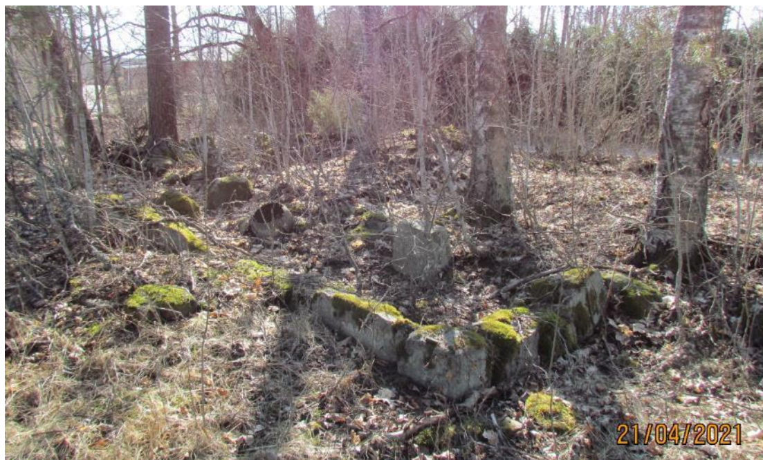
Kuva 95. Kesontien itäpuolella oleva kivijalka kuvattu pohjoisesta.
