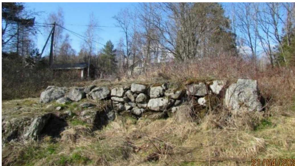
Kuva 92. Kallion päälle ja viereen tehty kivijalka. Kuvattu etelästä.
