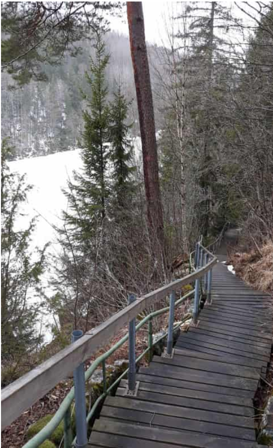
Kuva yllä vasemmalla: rantaan johtavat portaat
