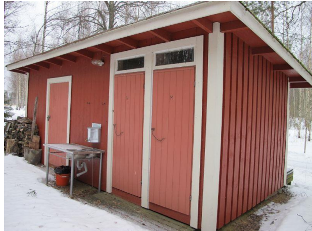
Työväentalon talousrakennus, jossa on mm. ulkokäymälät. Camilla Mitts 29.1.2018
