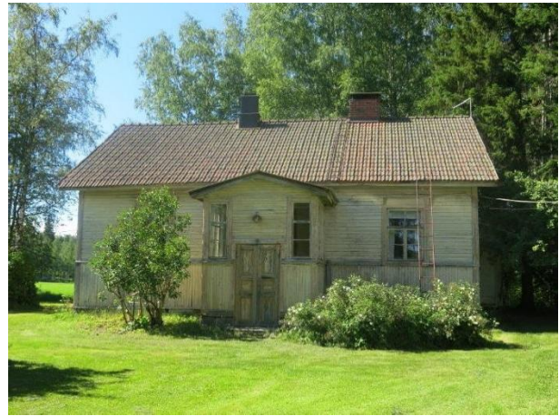
Keskikokoinen mautilan päärakennus Vehkapuntarin Iso-Annalassa.
