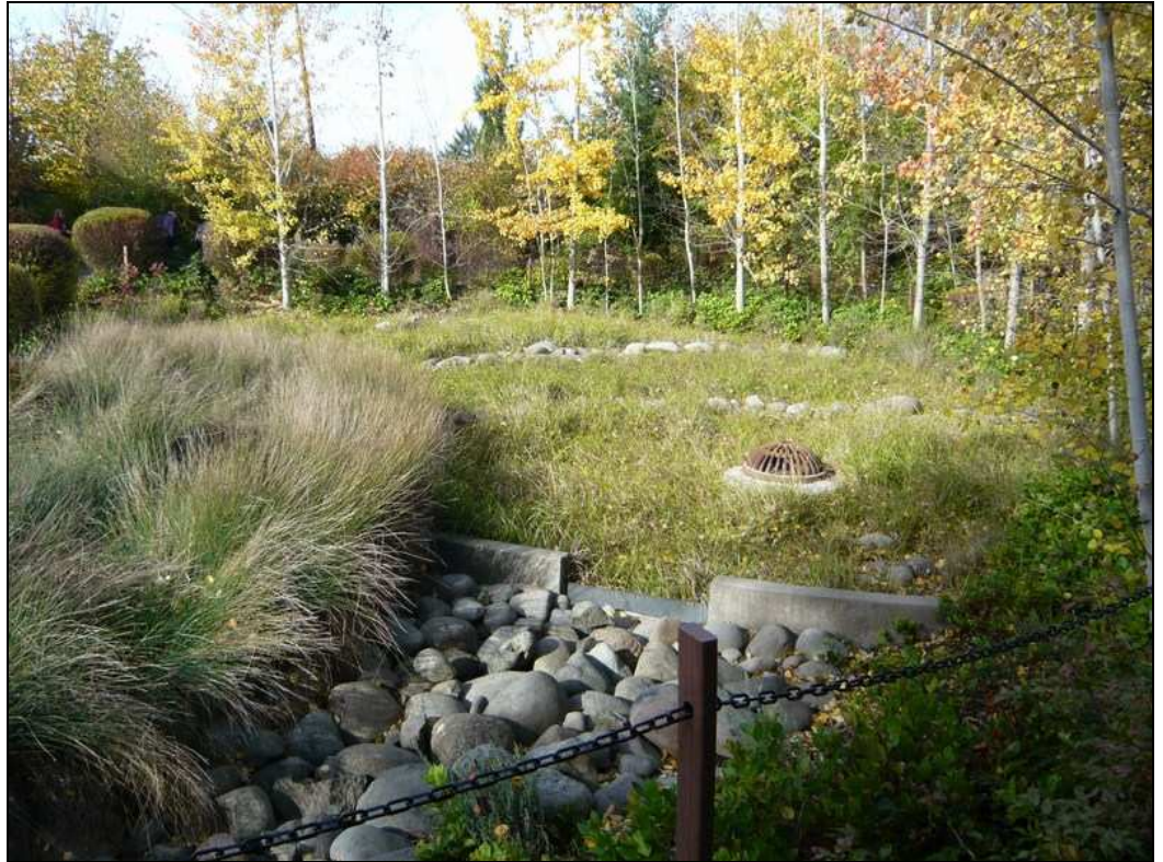
Kuva 8. Puistossa oleva biopidätysalue ylivuotokaivolla varustettuna 15 .
