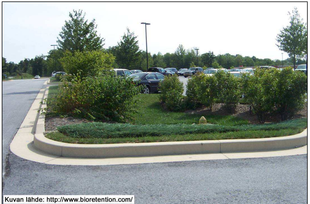
Kuva 9. Esimerkki biopidätysalueesta parkkipaikan vieressä.
