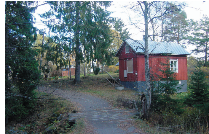
Saappaanpohjanojan silta Huhdintiellä.
