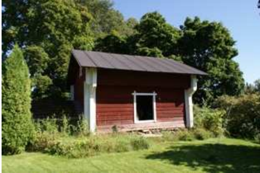
Kuvassa Frantsilan hirsinen yksinäisaitta puistomaisella piha-alueella. Mahdollisesti 1800-luvun alkuun palautuvan rakennuksen alla on kellari.
