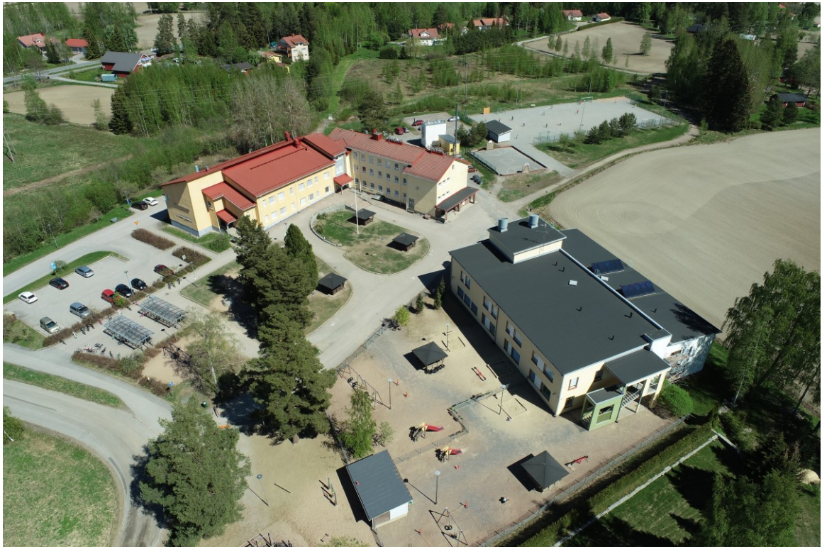
Kuva 3. Kuva Liuksialan koulun pihapiiristä kaakon suuntaan keväällä 2022. Taka-alalla on suunnittelualueen nykyistä muuta rakennuskantaa, aluetta halkova voimalinja sekä viherympäristöä.
