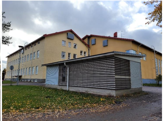
Vanhan koulurakennuksen ja uudisosan takana on yhdistetty jätekatos ja varastorakennus. Rakennus on yhtenäinen, ja siinä on vaaleanharmaan vaakalaudoituksen lisäksi osittain ruskea peiterimoitus.
