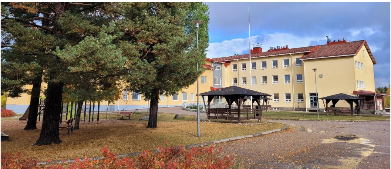
Liuksialan koulu etelästä (ylhäällä) ja lounaasta (alhaalla) tarkasteltuna.
