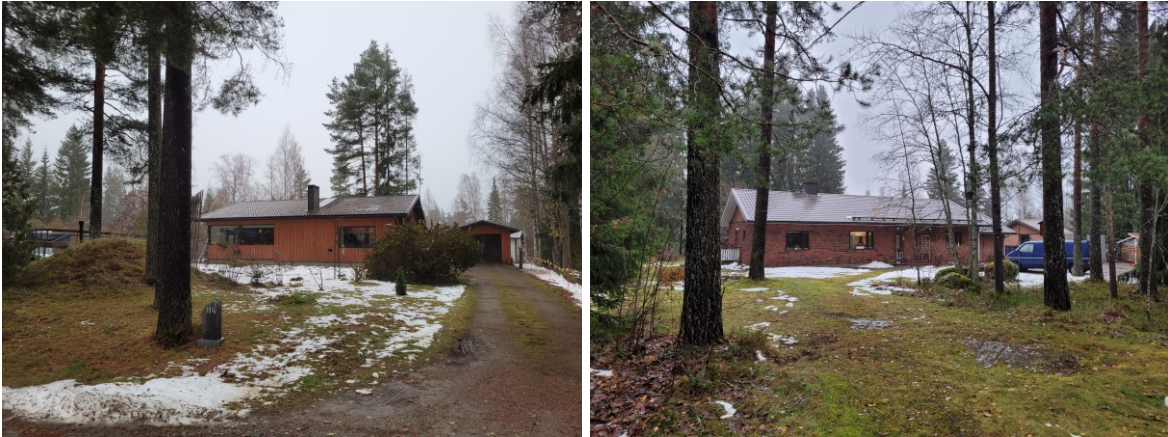
Kuva 27 Mäkikyläntien modernia rakennuskantaa 1980-luvulta. Vasemmalla Mäkikyläntie 114 ja oikealla Mäkikyläntie 98.
