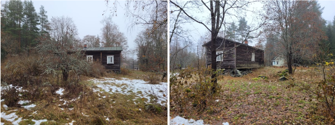
Kuva 32 Rakennuksen pohjoispäädyssä on ollut peiterimaverhous muun rakennuksen ollessa nykyään verhoilematonta hirttä.
