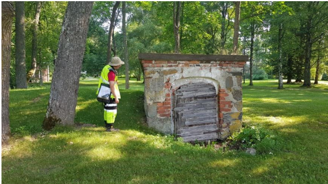
Kuva 8. Kalle Luoto tarkastelee kartanon puistoalueella sijaitsevaa vanhaa kellaria. Koilliseen. SK.
