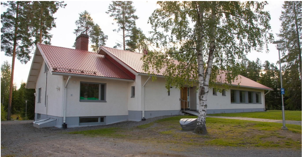
Kuva 1. Kuva Ruutanan seurakuntakodin rakennuksesta.
