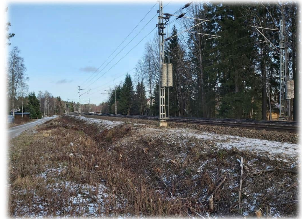
KUVA: Tampere-Orivesi –rata Vatialassa
