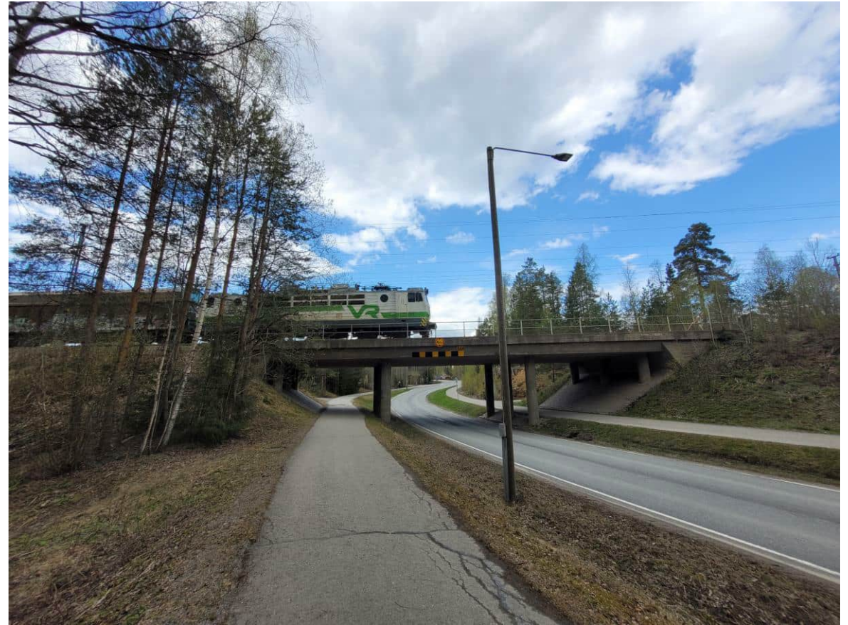
Kuva 2. Ruutanan alikulkusilta idästä päin.
