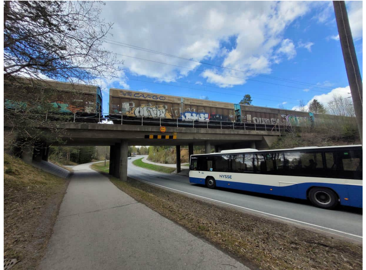
Kuva 2. Ruutanan alikulkusilta idästä päin.
