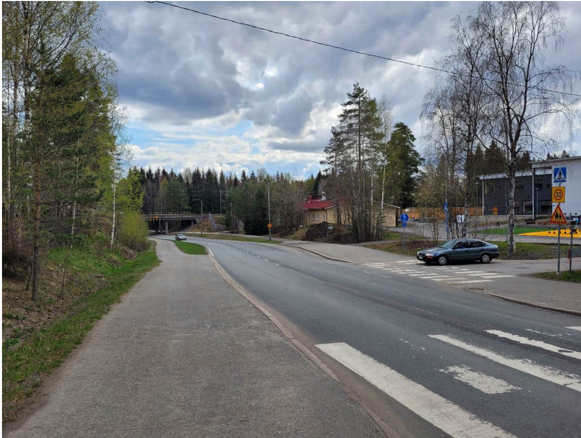
Kuva 1. Ruutanan alikulkusilta lännestä päin. Molemmiin puolin Ruutanan tietä on yhdistetty jalankulun ja pyöräliikenteen väylä. Oikealla monitoimitalo.
