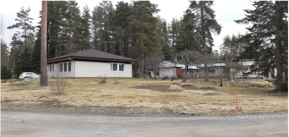
Kuva 4. Näkymä Suvisalontieltä kohti tonttia keväällä 2022. Tontin nykyinen päärakennus on yksikerroksinen ja aumakattoinen.
