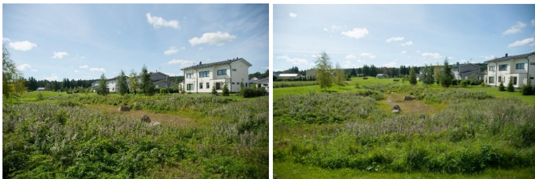
Kuvat 3.1 ja 3.2. Luonnonmukainen, normaalioloissa kuiva viivyty- ja imeytyspainanne Kangasalan Tursolassa Vaarinmaan asuinalueella kesällä 2017.
