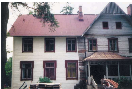
Lepokodin hirret harjattiin ennen maitomaalilla maa-laamista.
