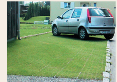
Vettäläpäisevä pintamateriaali pysäköintialueella
