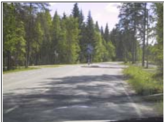
Asemantien ja Otsolantien liittymään on rakennettu suojatien keskikoroke.
