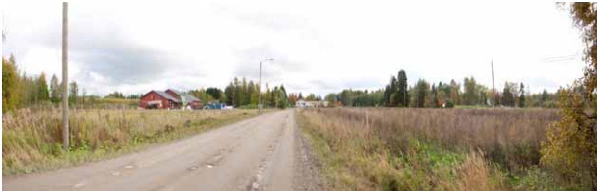
Panoraamakuva Kivisalmentielle Pento-ojan kohdalta itään päin nähtynä. Vasemmalla rakenteilla oleva päiväkotia.
