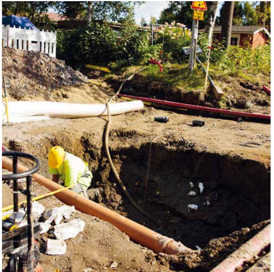
Saneeraus voidaan hoitaa myös sujuttamalla, jolloin pelkät liitoskohdat kaivetaan esille.
