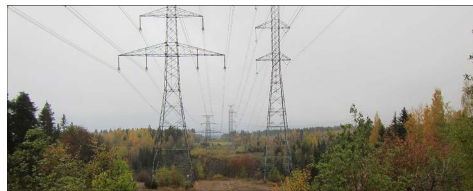
Kuva 53. Siltapaikka Ilkon puolelta katsoen.
