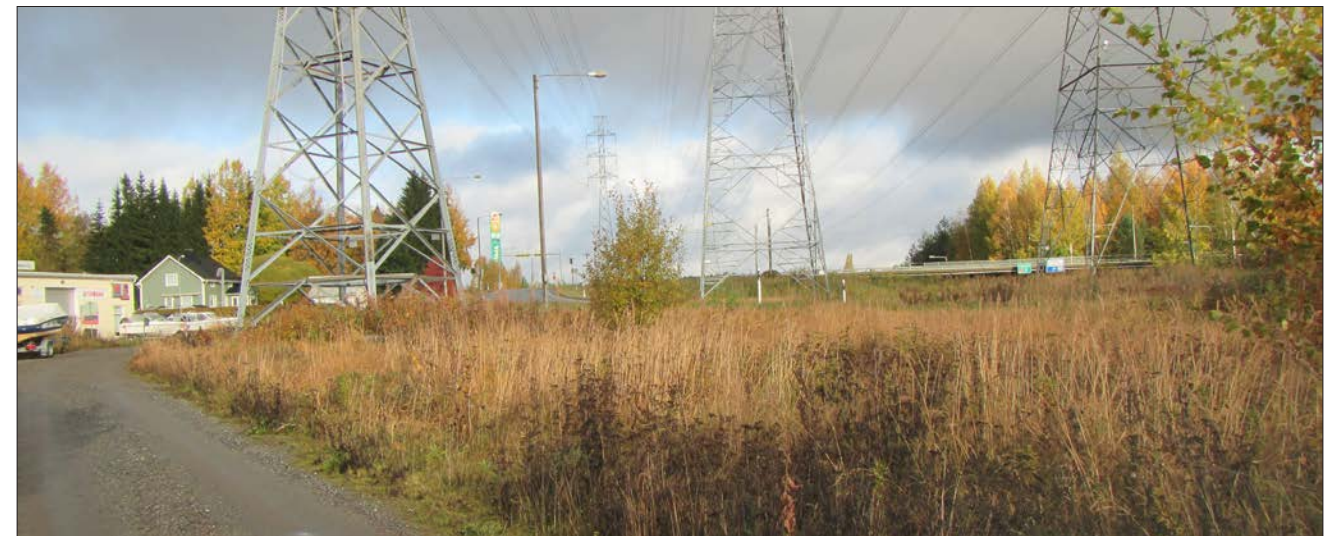
Kuva 34. Näkymä tielinjalta valtatie 12 eritasoliittymän suuntaan, voimajohtopylväät ja Prismän mainostorni.
