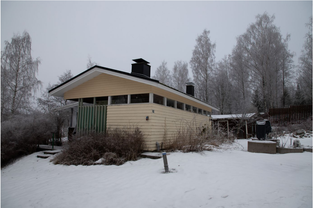
Kiinteistön Nuorronmaja 211-467-1-189 sauna- ja varastorakennus (6).
