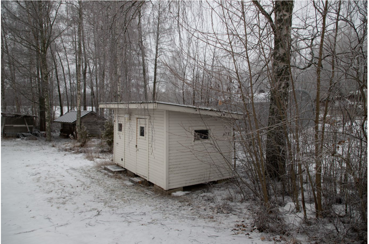
Kiinteistön Nuorronranta 211-467-1-188 talousrakennus (3).
